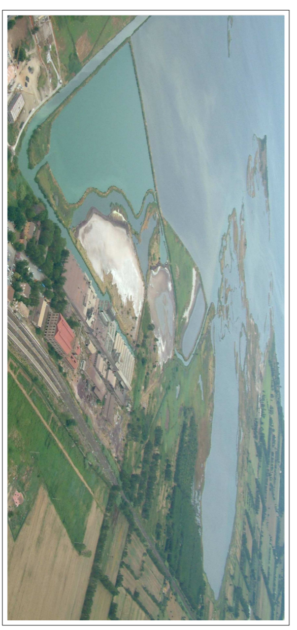
INTERVENTO DI RISANAMENTO AMBIENTALE DELL'AREA EX S.IT.CO DI ORBETTELLO SCALO
