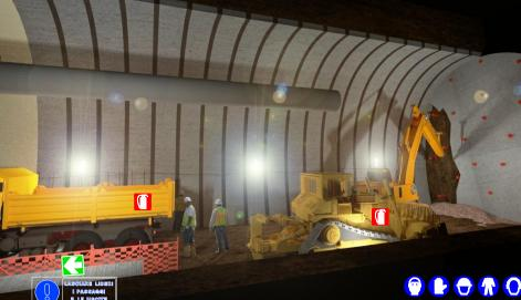
Lo scavo al fronte viene eseguito utilizzando un escavatore dotato di martello demolitore. Prima di dare inizio ai lavori, l'escavatorista verificherà il corretto funzionamento del climatizzatore di bordo. Durante lo scavo,
