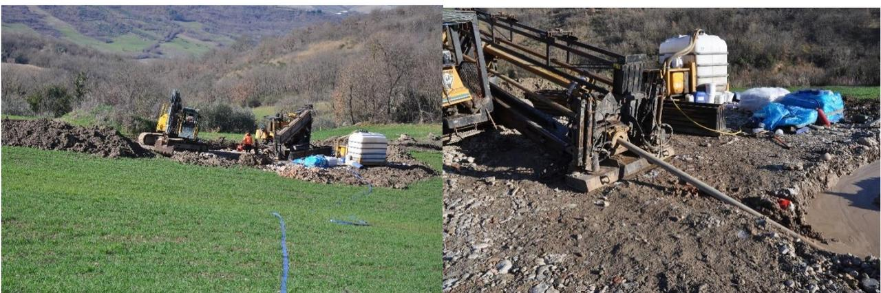
Figura 1.29. La perforazione teleguidata eseguita nella formazione del FYRavc, all'imbocco nord della galleria Grottaminarda (Progr. Km 4 +700).
