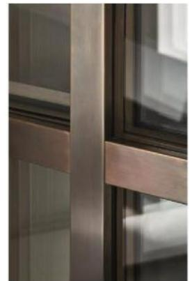
La facciata è completa di vetricamera applicata mediante pressore distanziato dal vetro da idonee guarnizioni interne ed esterne a filo. Stratigrafia della vetricamera come da progetto definitivo: vetri stratificati e temperati esterno 88.4 + camera da 16 con gas argon + interno 66.4 basso emissivo.
