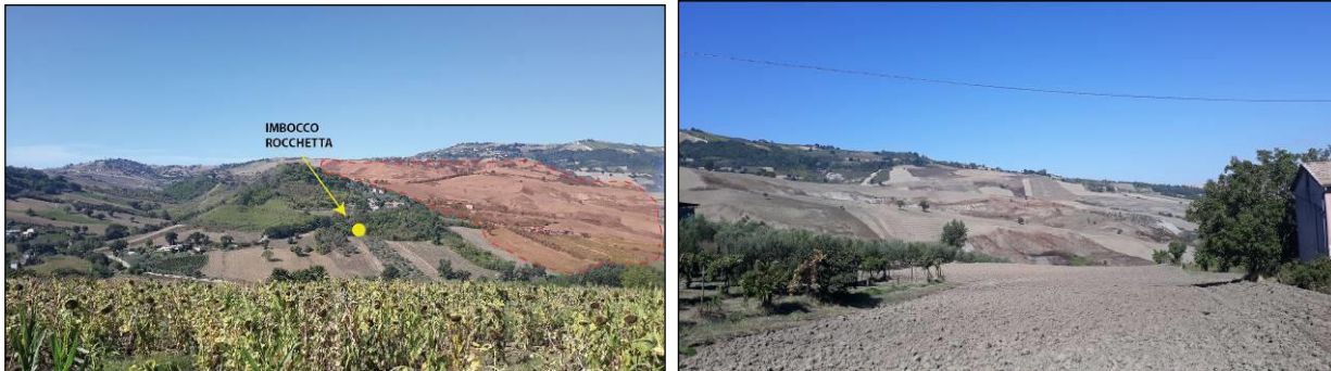
Figura 18 – Panoramica del versante dell’imbocco lato Bari della Galleria Rocchetta in cui è segnato il versante (in rosso) caratterizzato da importanti movimenti franosi attivi (sx). Dettaglio di un settore di frana attivo (dx)
