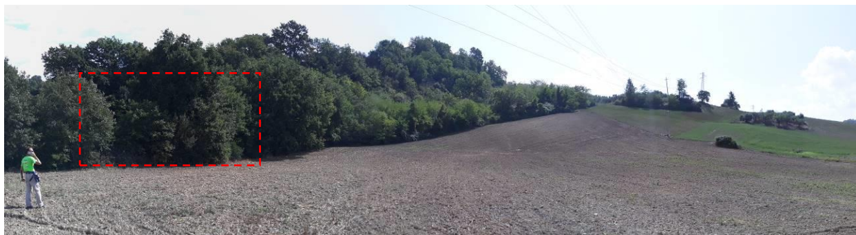
Figura 21 – Imbocco lato Napoli della Galleria Rocchetta (GA06)
