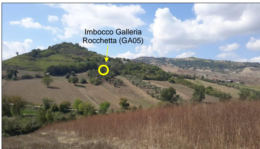
Figura 15 – Panoramica del versante in cui è previsto l'imbocco lato Bari della galleria Rocchetta.
