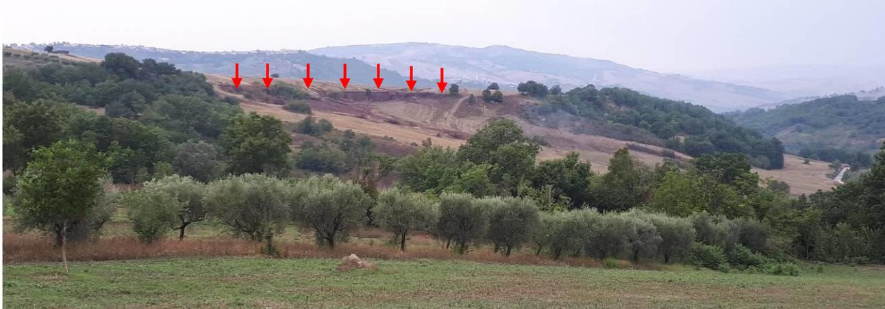
**Figura 30. Foto con vista laterale del fianco sinistro della nicchia del corpo principale di frana (le frecce rosse indicano la posizione della scarpata principale lungo cui si assiste al denudamento del substrato calcareo).**
