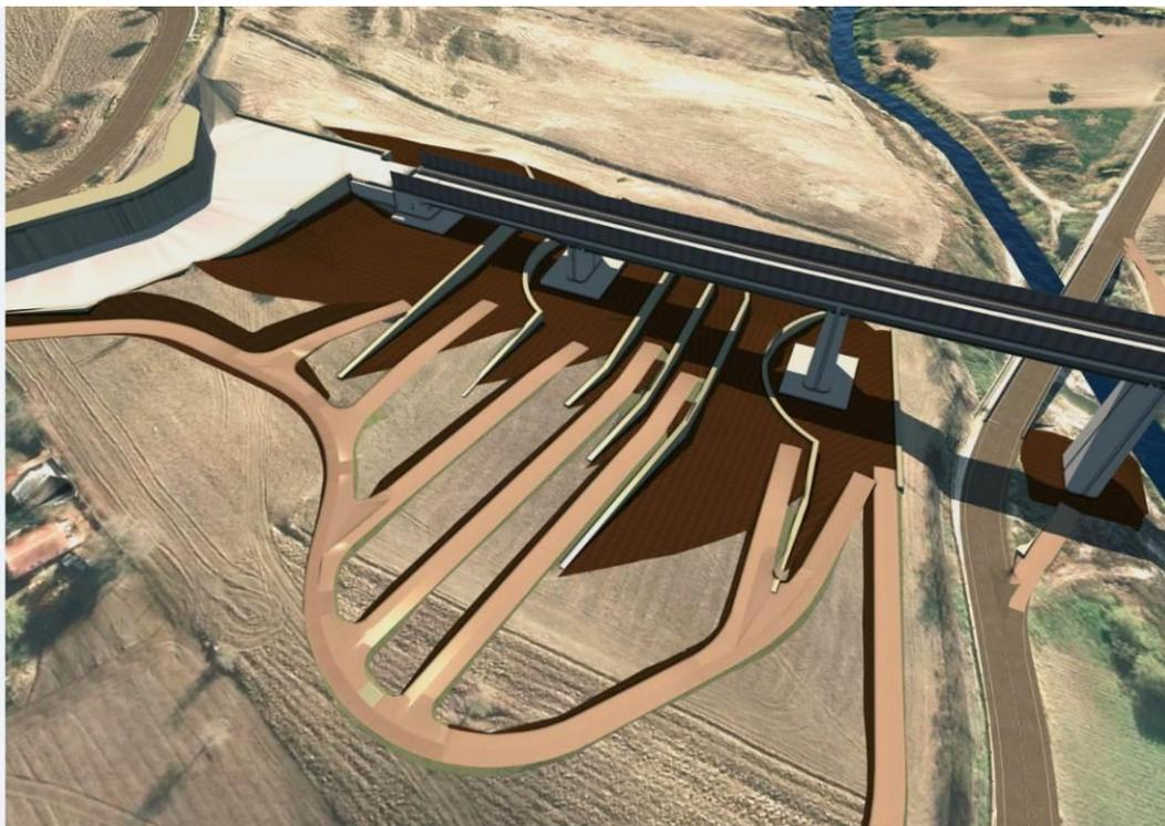
Figura 8-17. Viadotto VI03: Gradonatura del versante e opere di stabilizzazione versante Est – lato Galleria Melito
