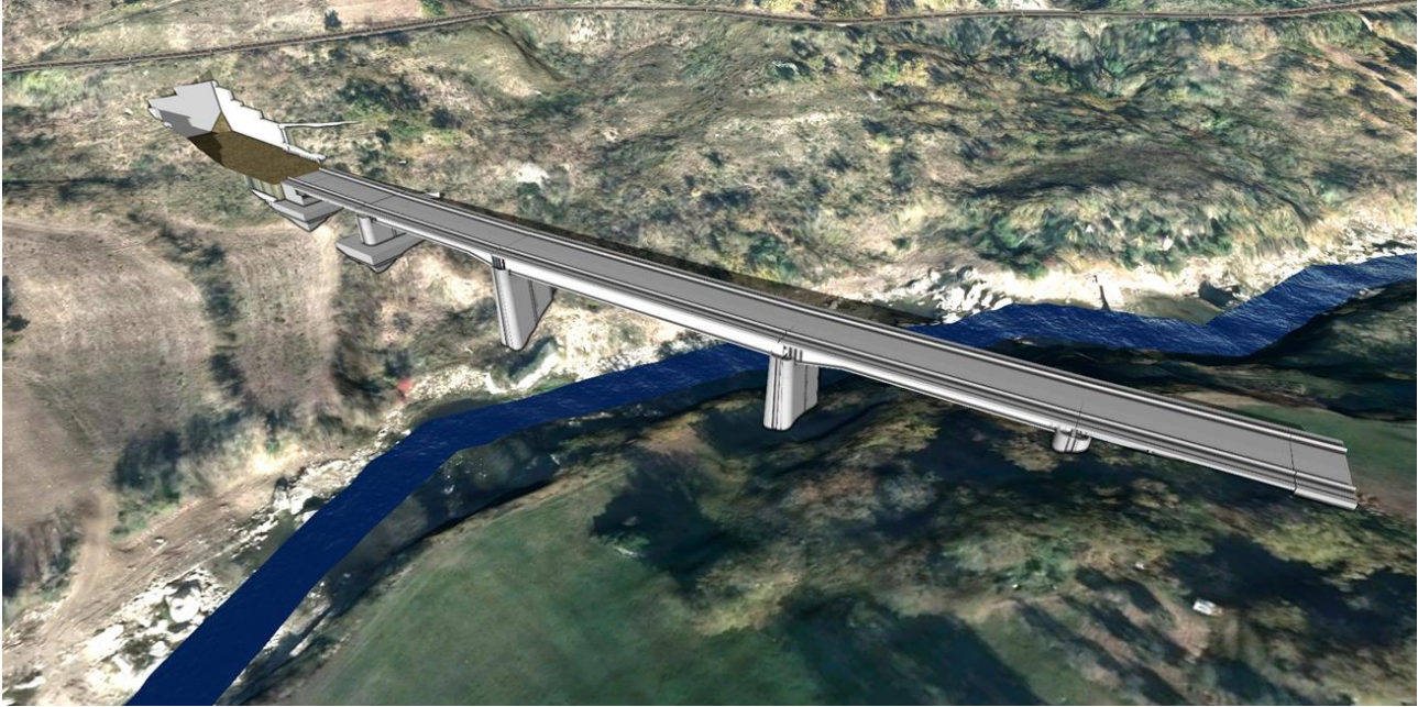
Figura 5.19. Vista 3D viadotto: soluzione a 5 campate
