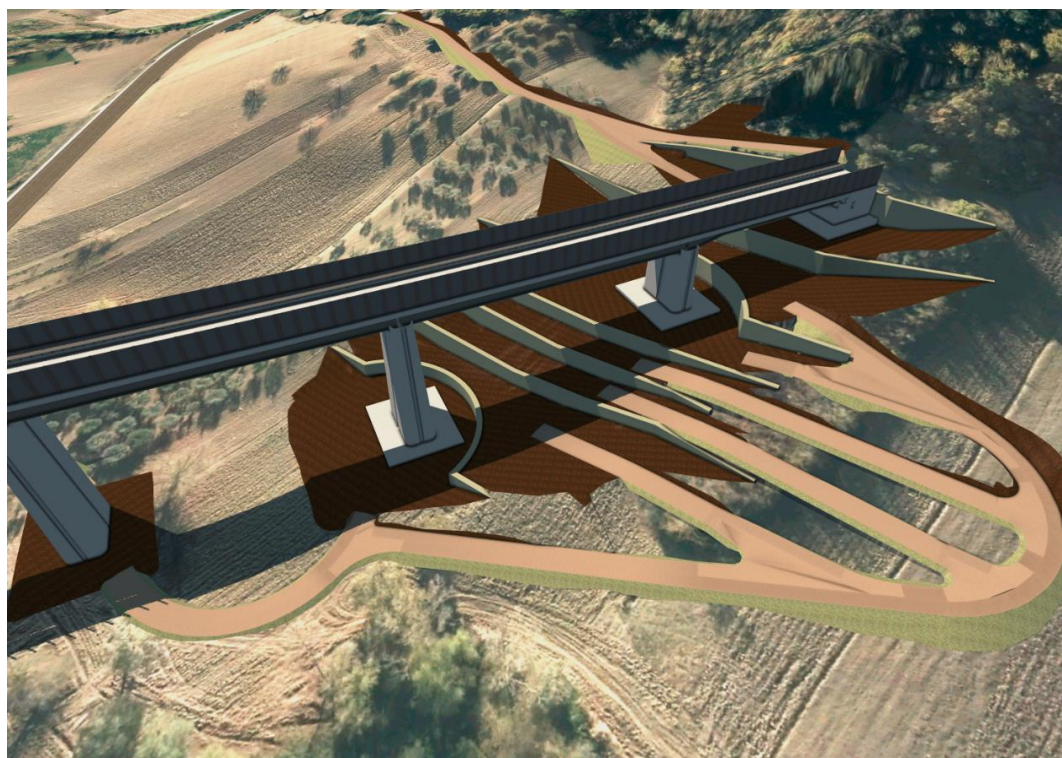
Figura 5-38. Viadotto VI03: Gradonatura e opere di stabilizzazione versante Ovest – lato Galleria Rocchetta
