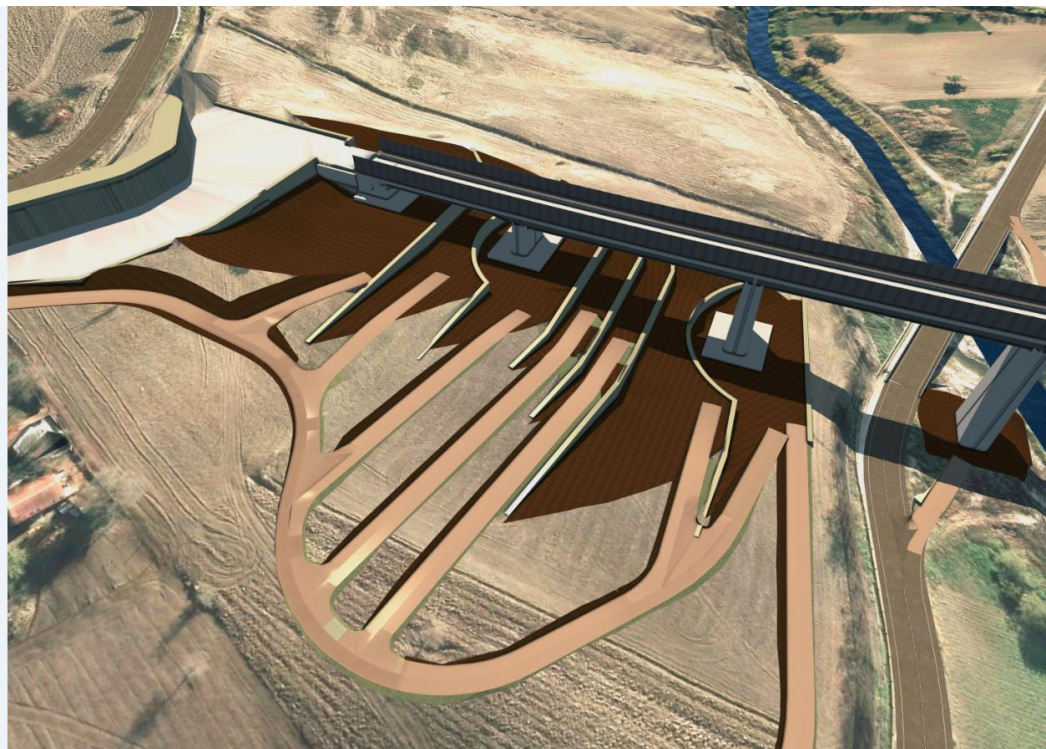
Figura 5-37. Viadotto VI03: Gradonatura e opere di stabilizzazione versante Est – lato Galleria Melito
