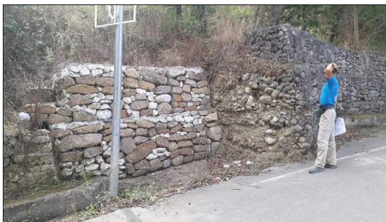
Figura 7 – Rottura dei gabbioni di contenimento ad opera di movimenti franosi attivi lungo strada a monte di Castel Fiego.
