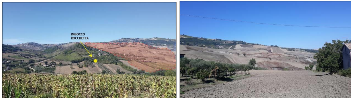
Figura 5 – Panoramica del versante dell'imbocco lato Bari della Galleria Rocchetta in cui è segnato il versante (in rosso) caratterizzato da importanti movimenti franosi attivi (sx). Dettaglio di un settore di frana attivo (dx)
