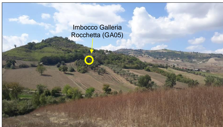
Figura 2 – Panoramica del versante in cui è previsto l'imbocco lato Bari della galleria Rocchetta.
