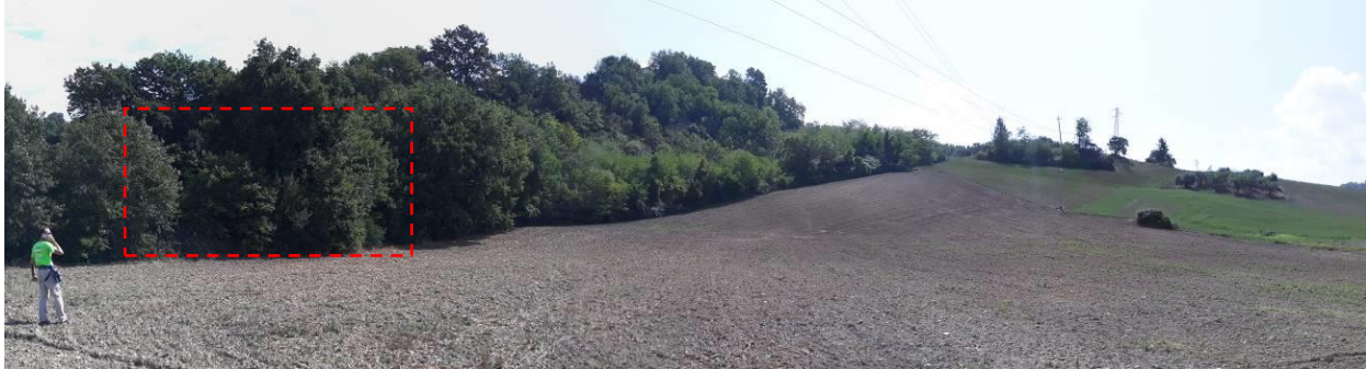
Figura 8 – Imbocco lato Napoli della Galleria Rocchetta (GA06)
