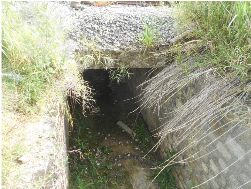
Figura 23 – Inalveazione IN05 – tombino esistente a monte del tratto che viene deviato. Immagine da sopralluogo
