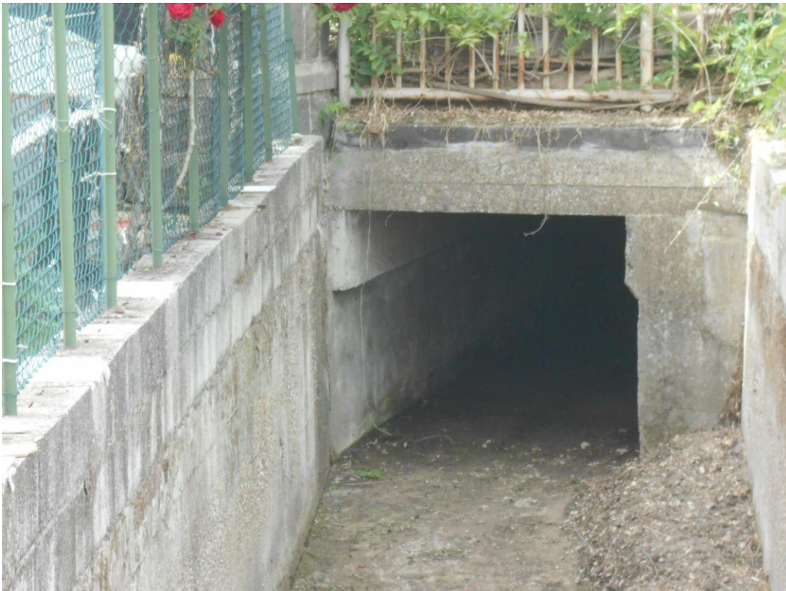
Figura 20 – Inalveazione IN04 – tombino esistente. Immagine da sopralluogo
