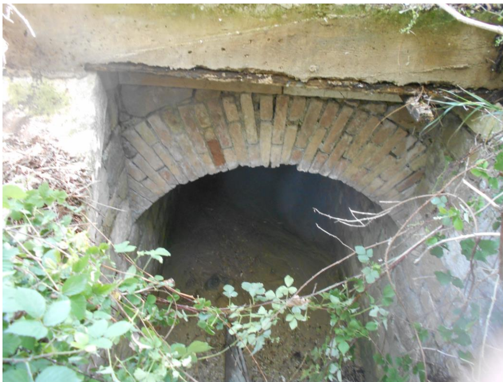
Figura 16 – Inalveazione IN03 – tombino esistente. Immagine da sopralluogo
