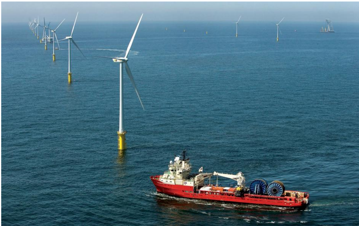
Figura 19: Posa dei cavi sottomarini
