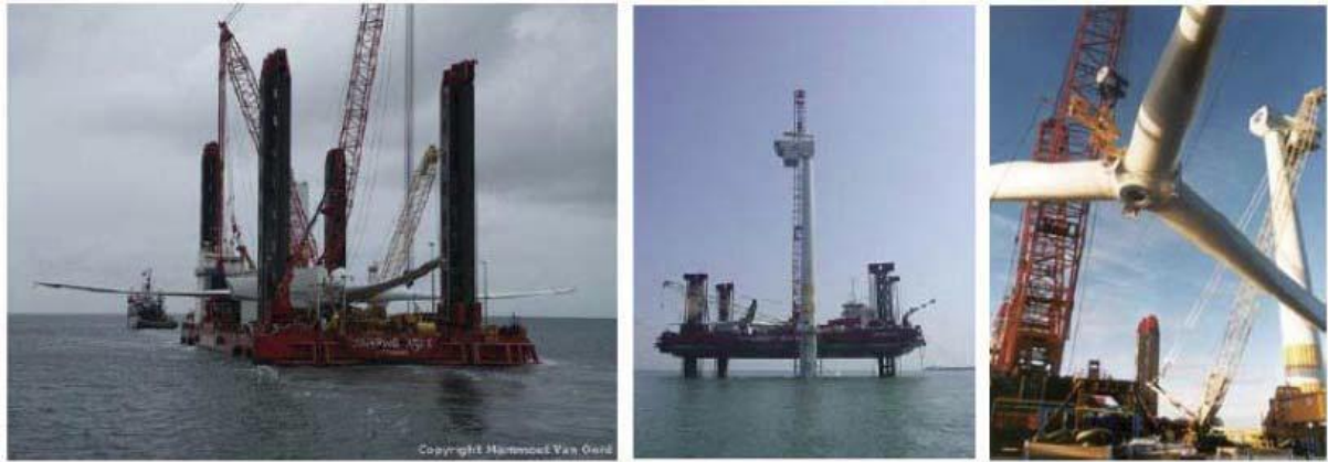
Figura 18: Installazione della turbina da 3,6 MW, con il metodo tradizionale, nel progetto di Arklow.
