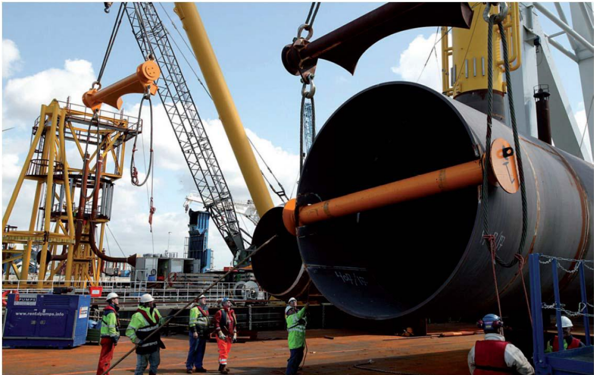
Figura 13: Fase di sollevamento dei pali di fondazione.
