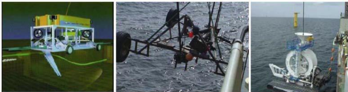
Figura 20: Mezzi utilizzati per l'interramento dei cavi.
