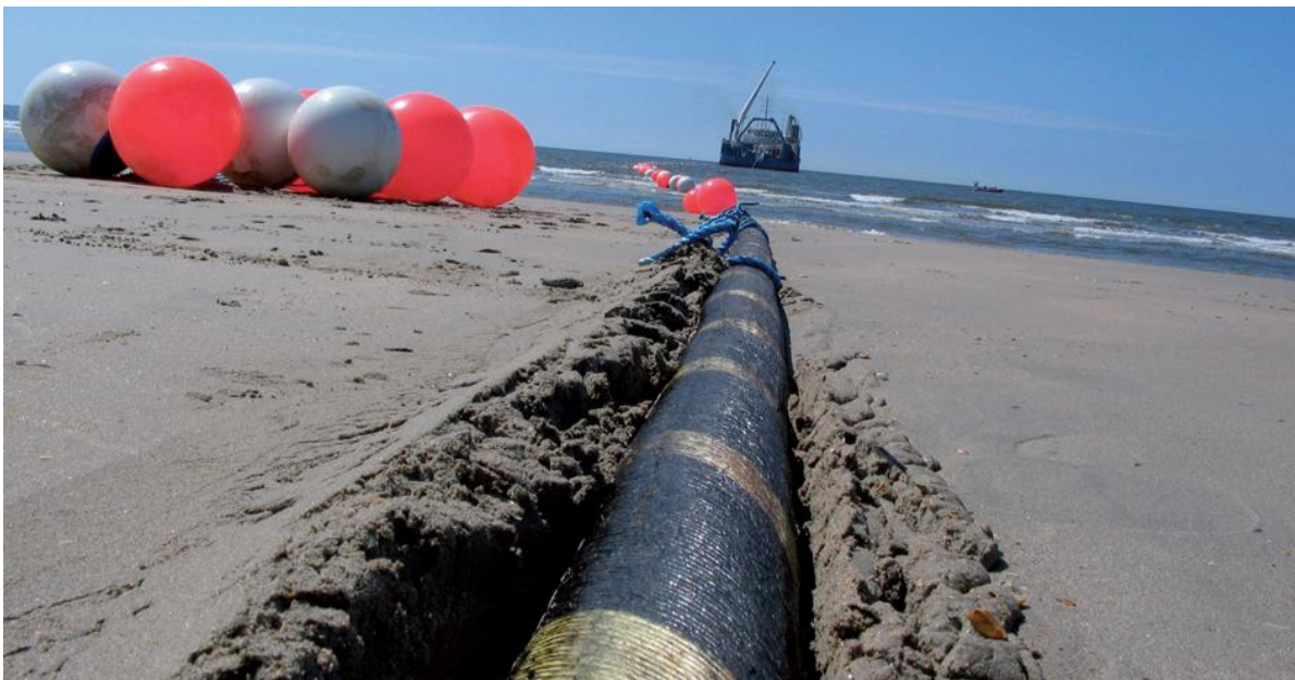
Figura 21:Attraversamento dei cavi lungo la costa.
