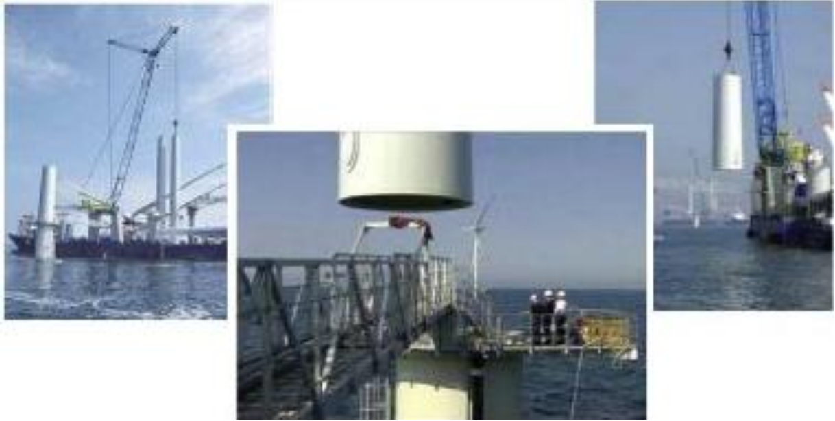
Figura 16: Installazione della torre in due componenti nel progetto di Horns Rev.
