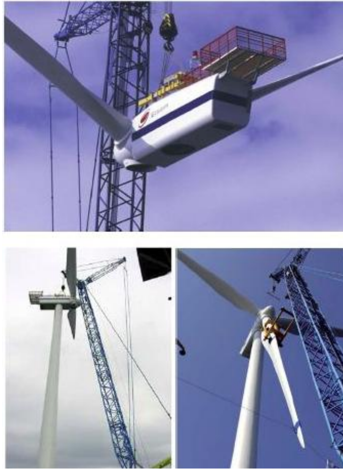
Figura 17: Installazione della turbina con il metodo bunny ear.
