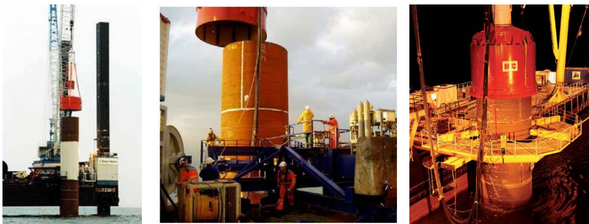
Figura 14: Fase di sollevamento martello e successivo posizionamento in corrispondenza della testa del palo.
