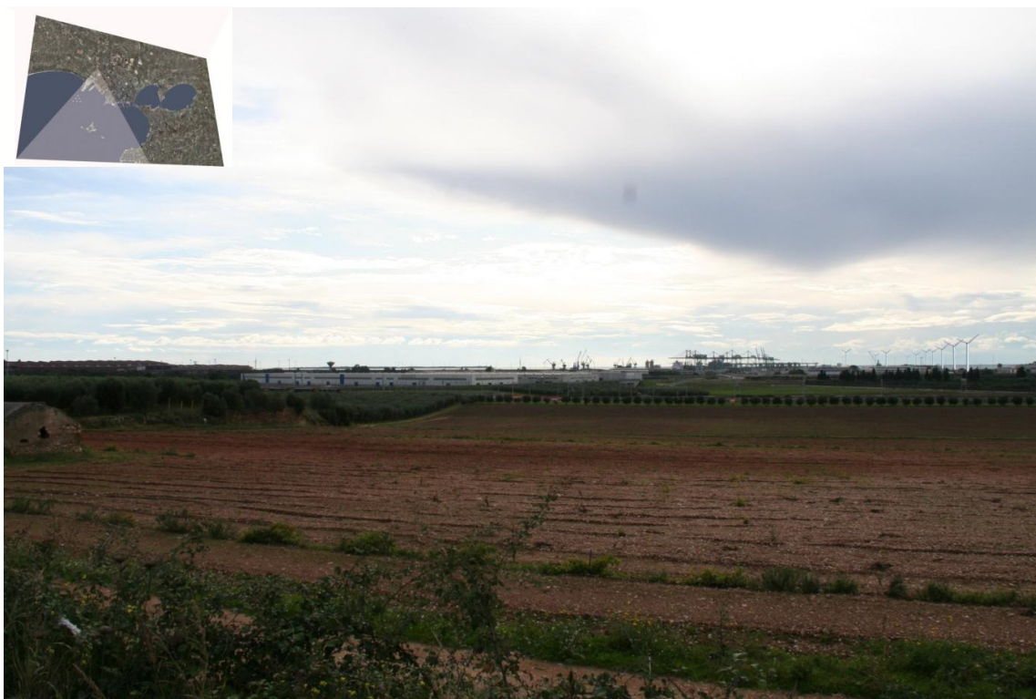
Figura 108. Fotoinserimento n. 7. Vista del Parco eolico dalla SS 7 alla radice del Molo Polisetoriale.
