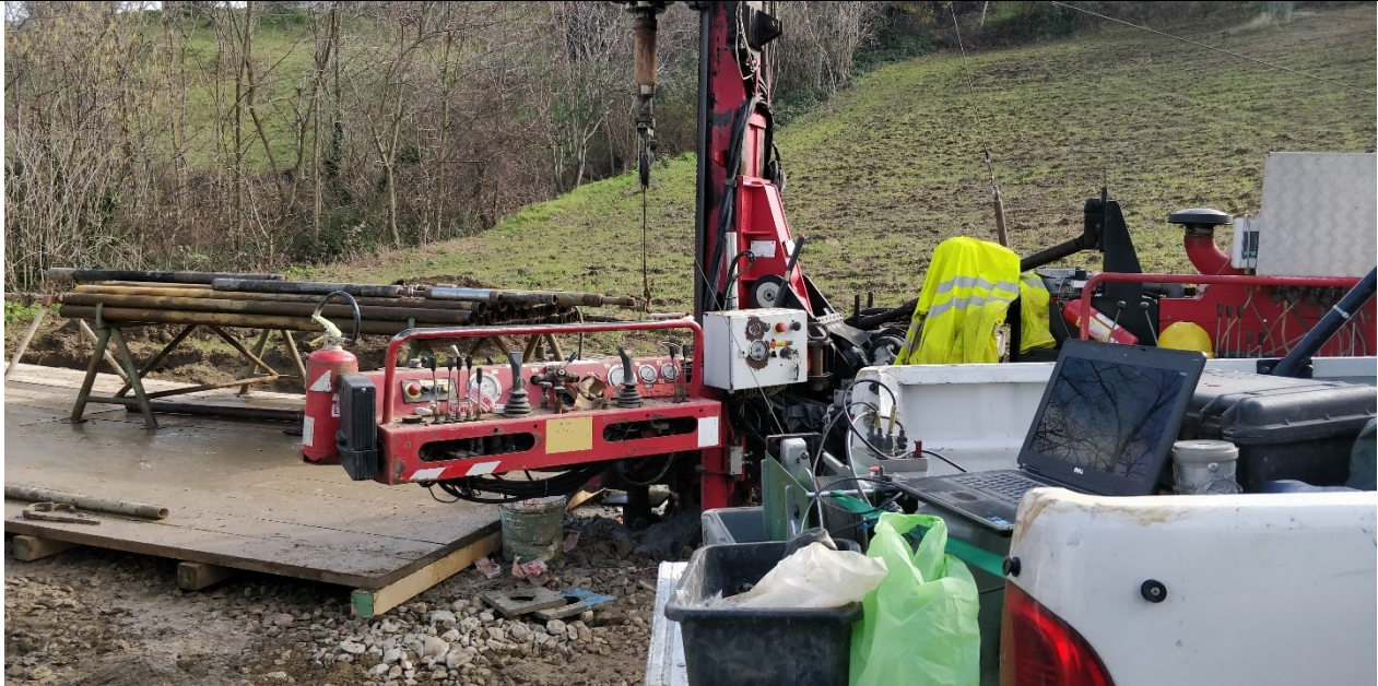
Fig. 2: Foto del sondaggio SROC5
