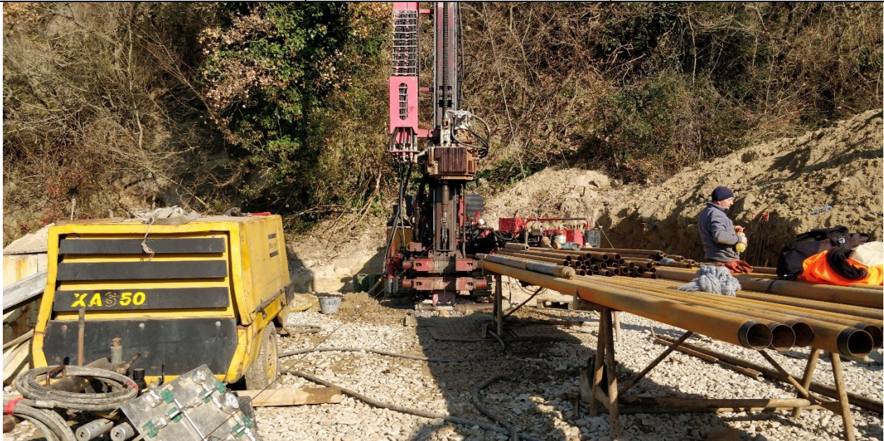
Fig. 2: Foto del sondaggio SROC6
