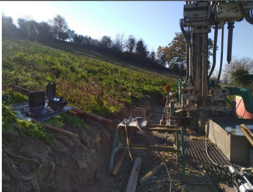
Fig. 2: Foto del sondaggio SROC7
