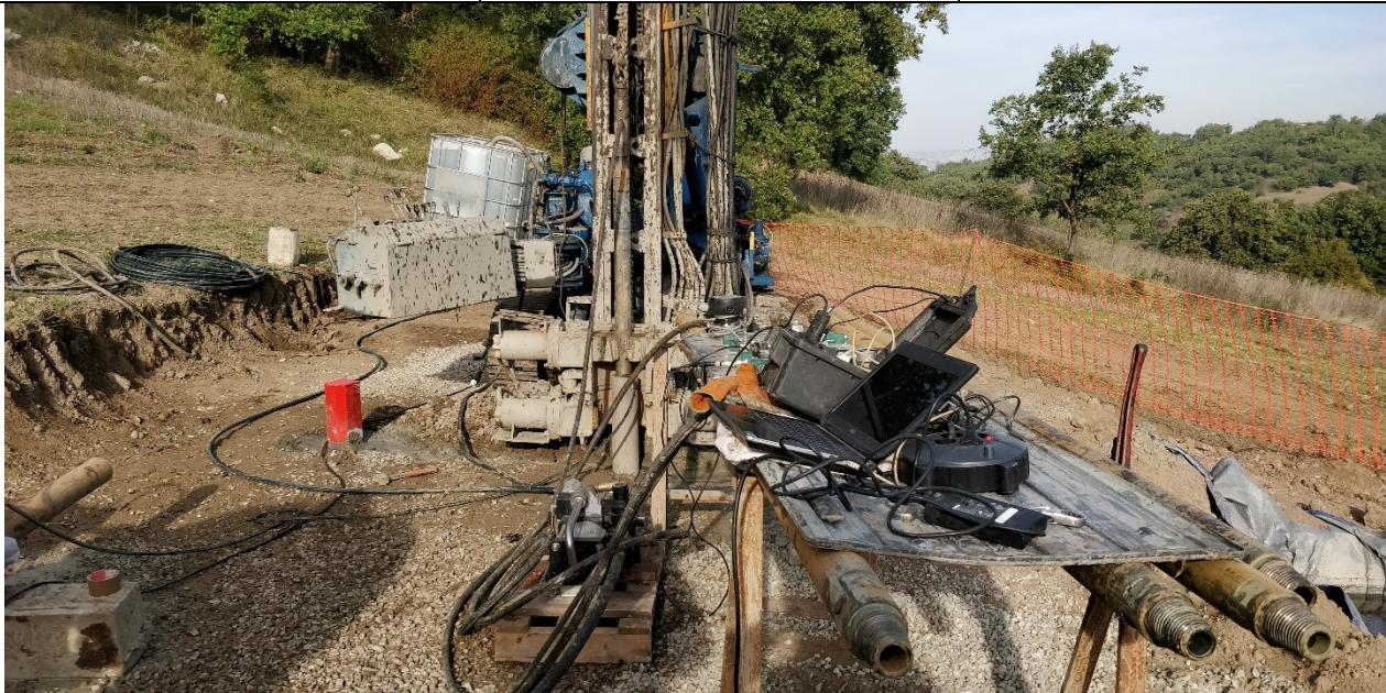
Fig. 2: Foto del sondaggio SN_GR_06
