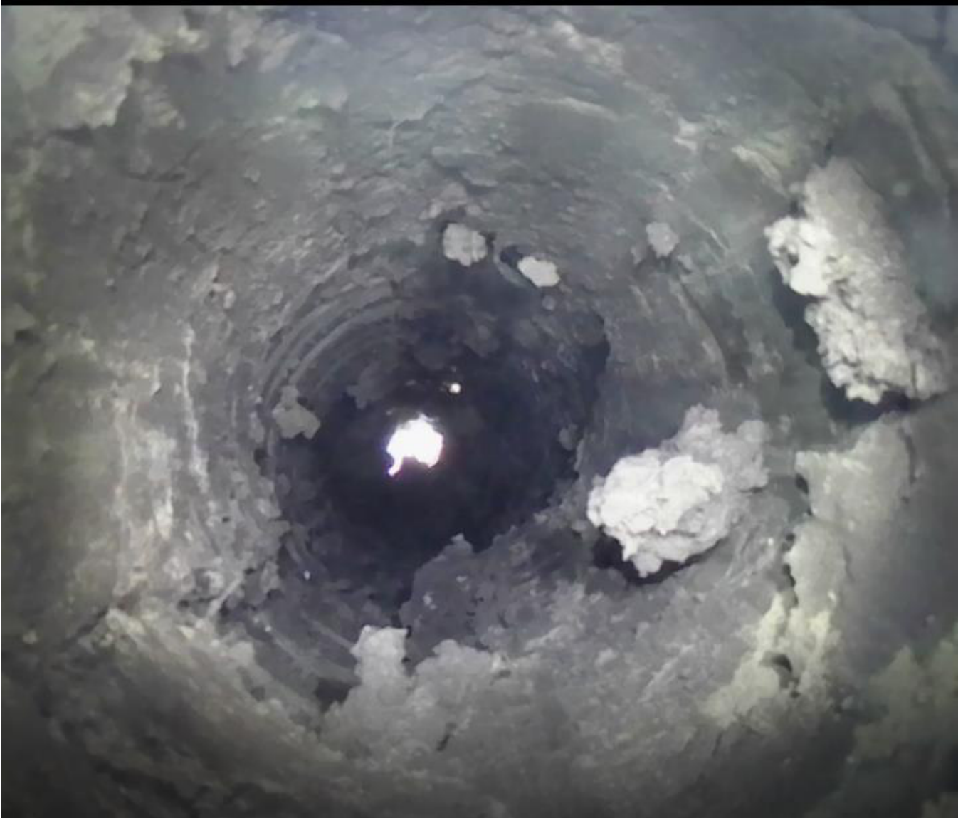
Figura6 : Immagine del tratto percorso (progressiva ~ 012/015 mt)
