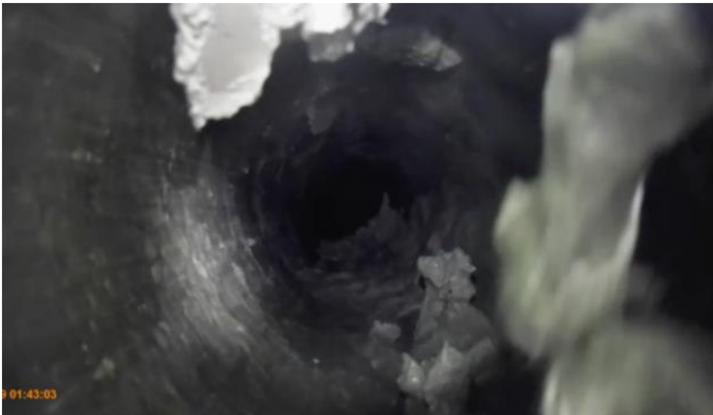
Figura6.a : Immagine del tratto percorso (progressiva ~ 035 mt)
