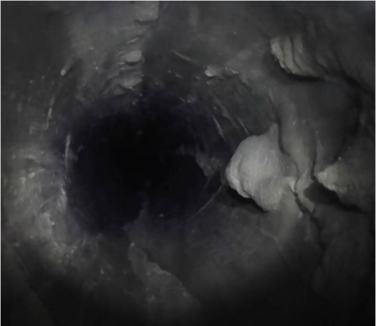
Figura6.b : Immagine del tratto percorso (progressiva ~ 035 mt)
