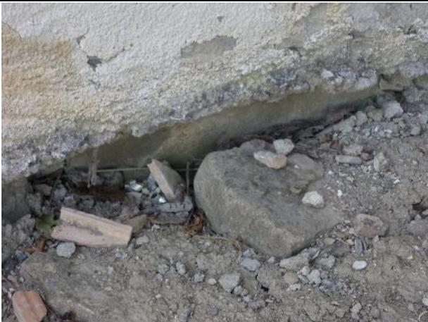
Connessione fra elevazione e fondazione in prossimità della zona laterale lato esterno
