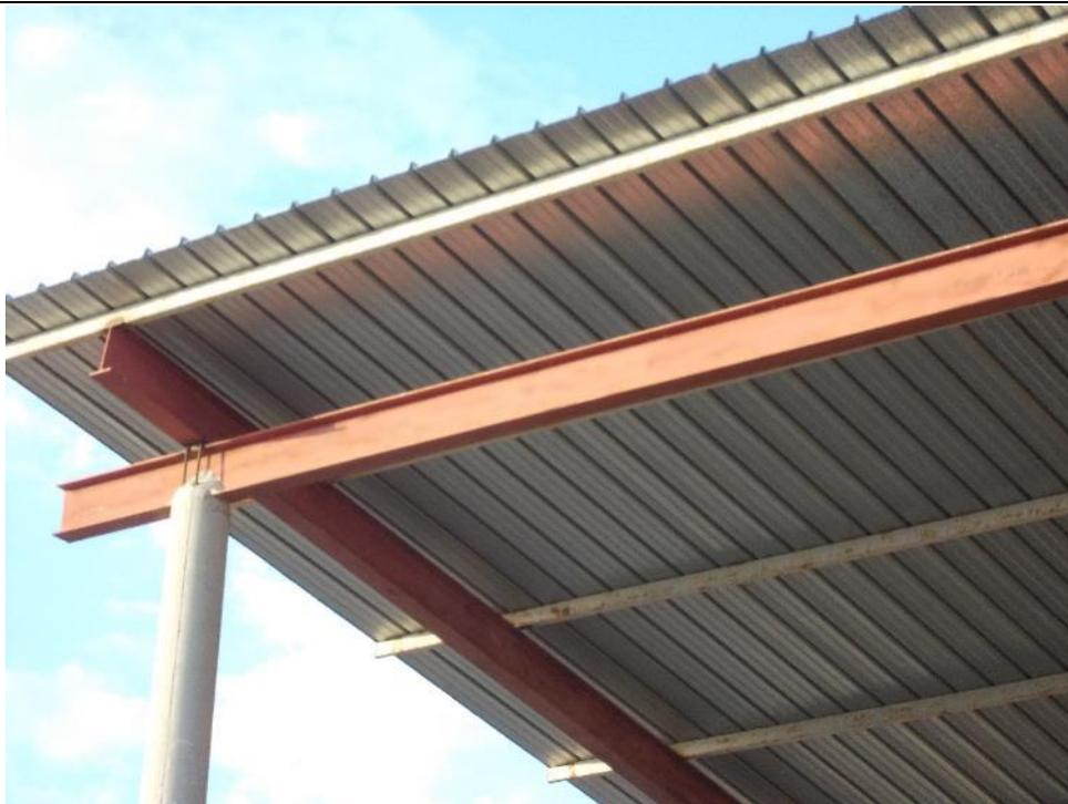
Particolare connessione fra copertura e pilastri verticali.
