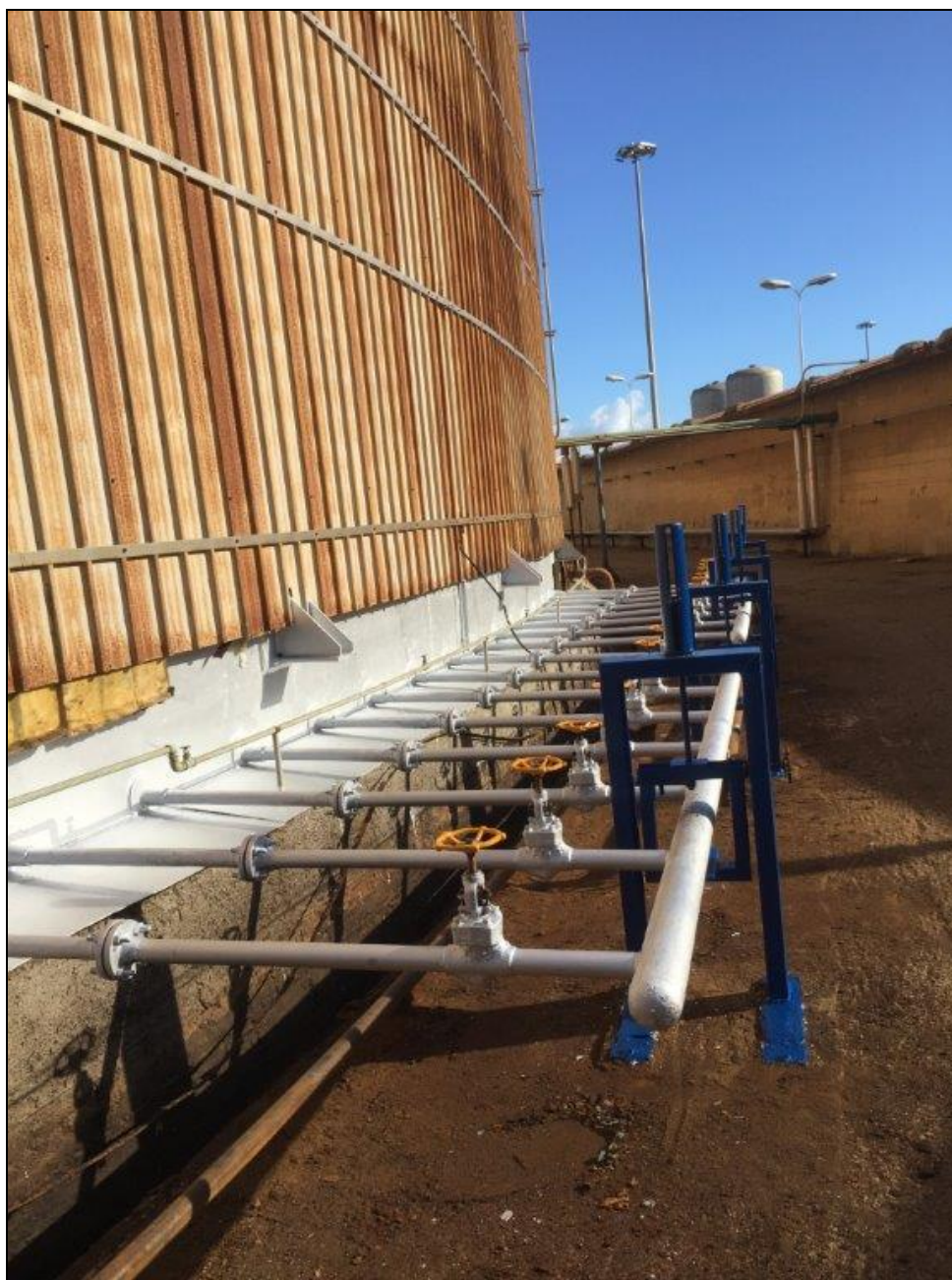
FOTO 1 - Completamento ripristino collettori e serpentine uscita 1°-2° banco
