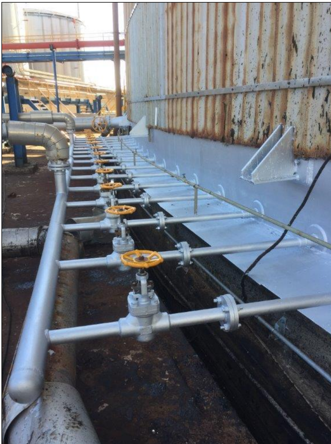
FOTO 2 - Ripristino con verniciatura collettori e serpentine ingresso 1°-2° banco
