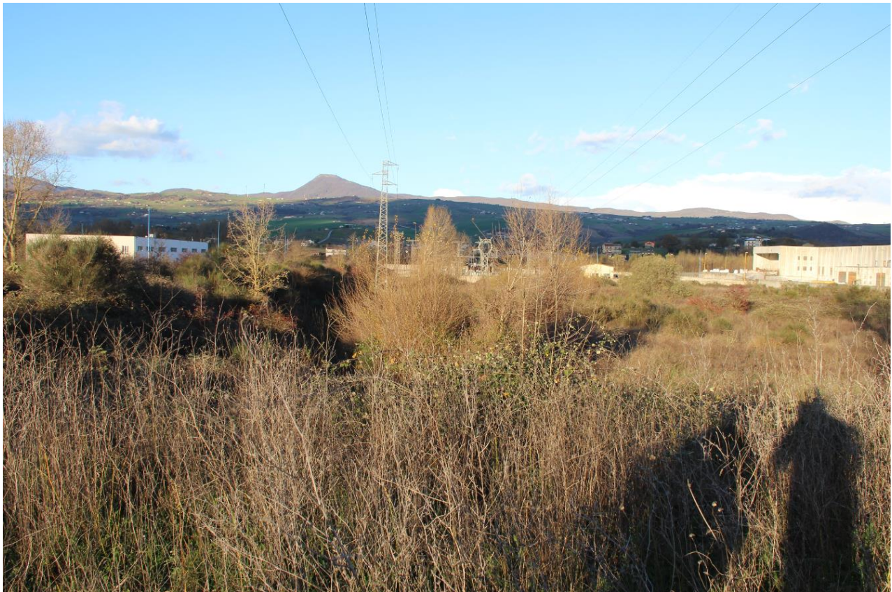
Figura 16: Foto dell'area della sottostazione
