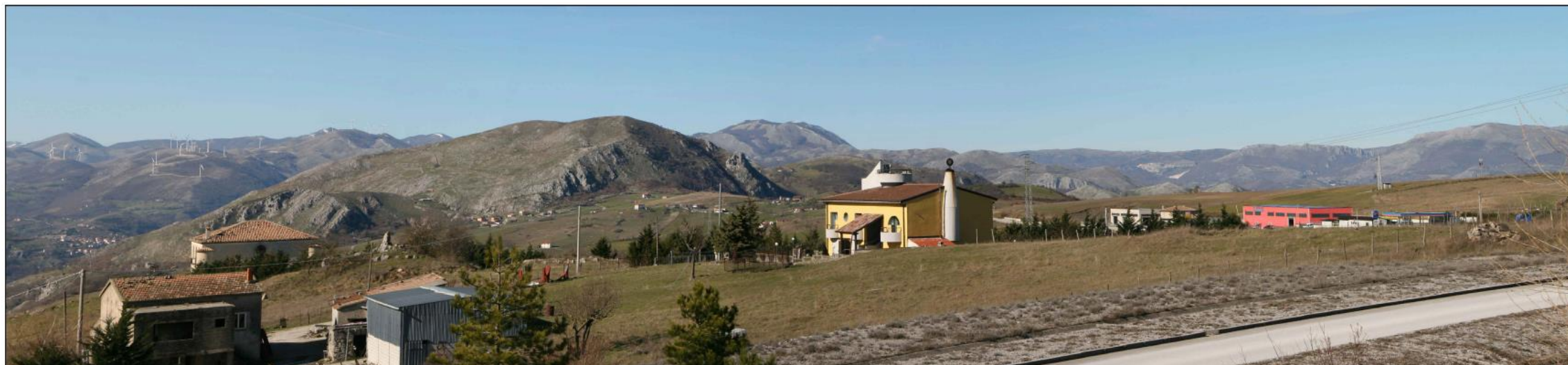
Vista del sito oggetto dell'intervento dall'area industriale di Balvano, prima dell'intervento
