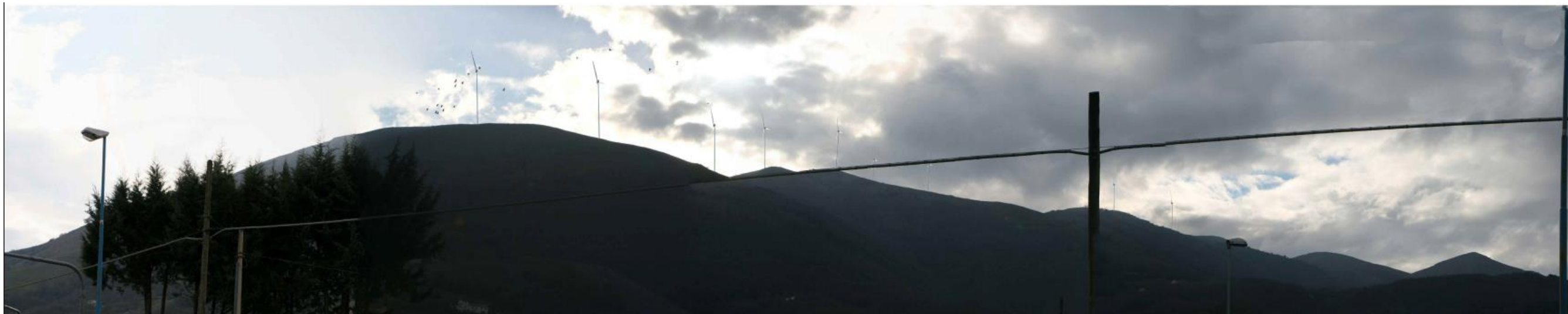
Vista del sito oggetto dell'intervento dall'area artigianale di Muro Lucano, layout autorizzato
