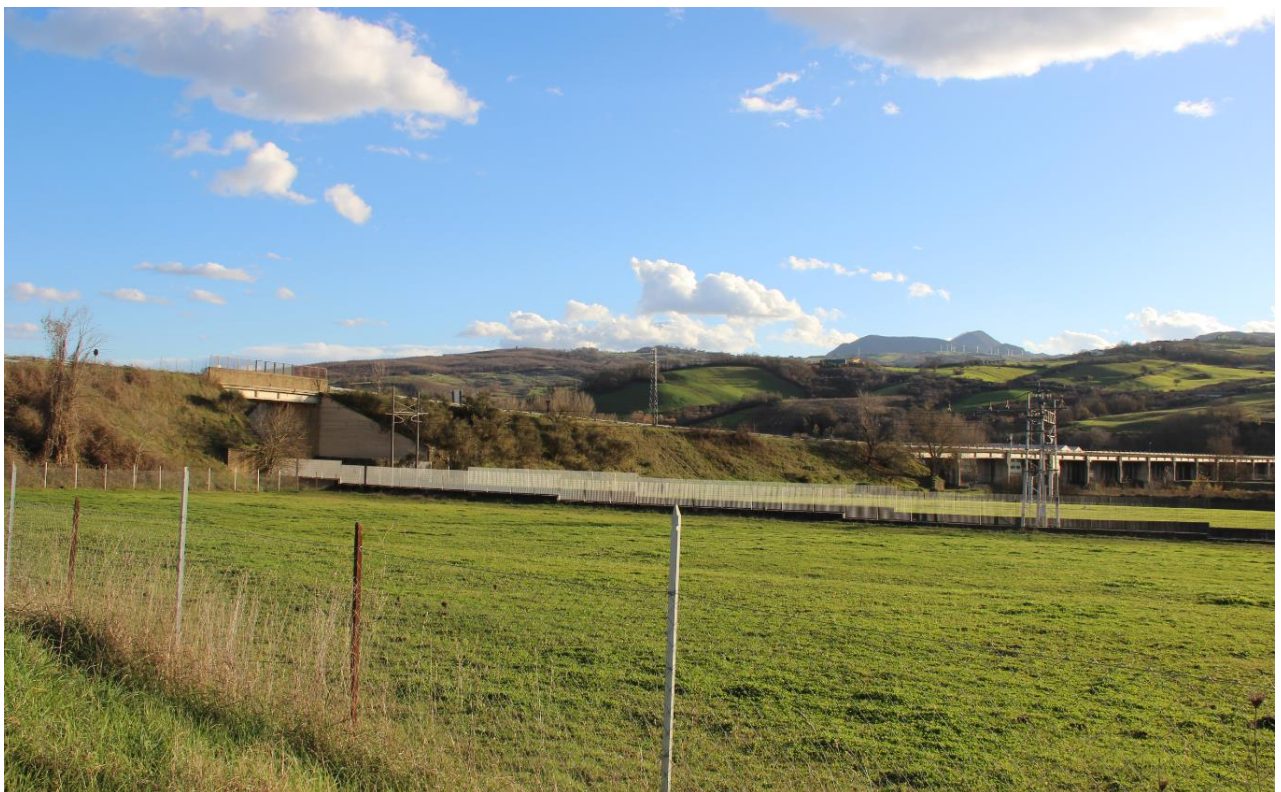
Figura 15: Foto del viadotto che supera la Salerno-Potenza e il fiume Platano
