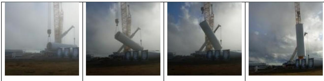
Figura 6.16 – Schema delle fasi di sollevamento dei componenti dell'aerogeneratore (Fonte sito web <http://www.windfarmbop.com/> )
