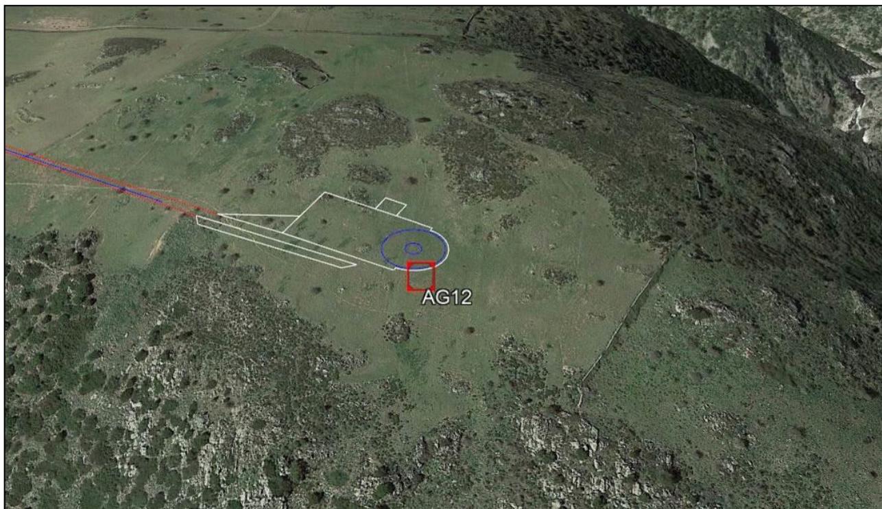
Figura 2.9 – Foto aerea dell’ambito morfologico al contorno dell’aerogeneratore AG12 (Settore G4- Aree 4/5) Mentre il sito di imposta dell’impianto risulta sostanzialmente sub pianeggiante, al contorno si osservano i pendii rocciosi molto acclivi che delimitano il sovrastante pianoro. Fonte: Google Earth 2017.
