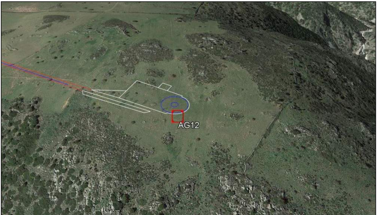
Figura 4.5 – Foto aerea dell'ambito morfologico al contorno dell'aerogeneratore AG12 (Settore G4- Aree 4/5) Mentre il sito di imposta dell'impianto risulta sostanzialmente sub pianeggiante, al contorno si osservano i pendii rocciosi molto acclivi che delimitano il sovrastante pianoro. Fonte: Google Earth 2017.
