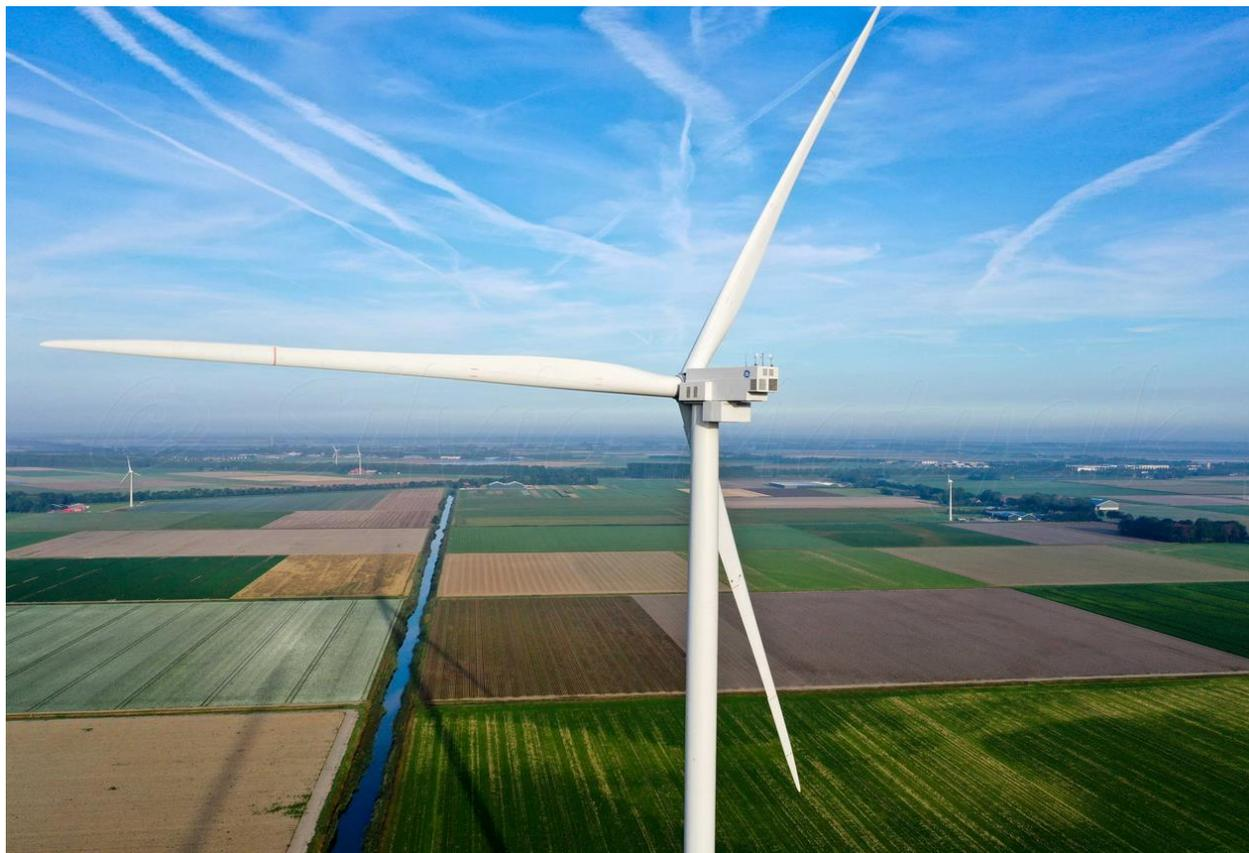
Figura 5.4 – Aerogeneratore tipo GE con diametro rotore 158 m
