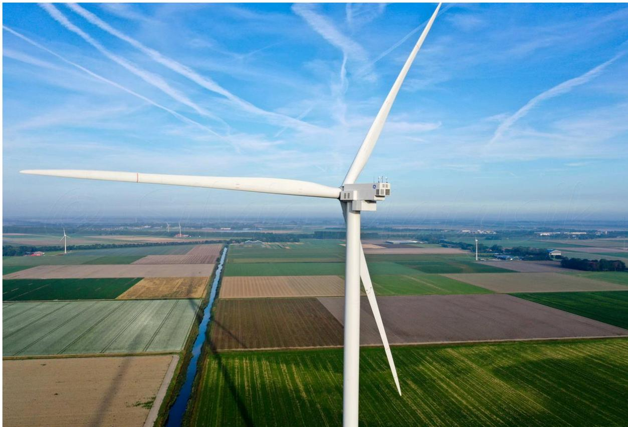
*Figura 5.2 – Aerogeneratore tipo GE con diametro rotore 158 m*
