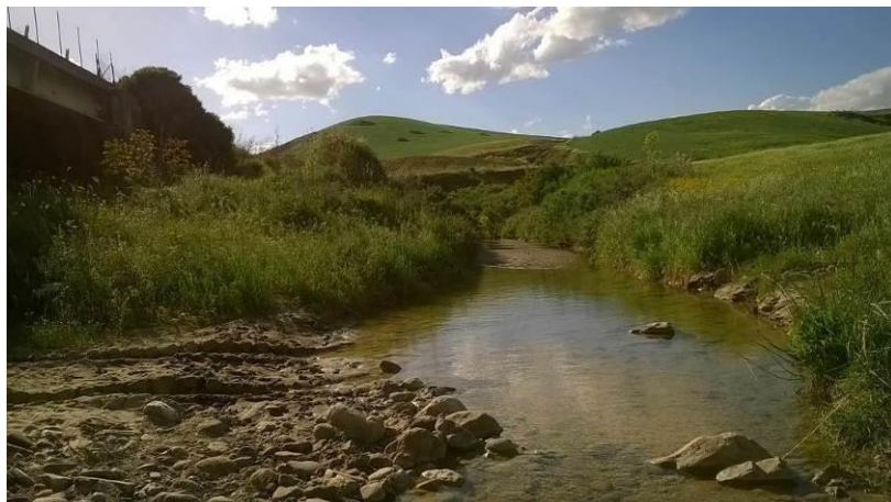
Figura 79 - Fossa Sparagogna_Foto a monte attraversamento stradale
