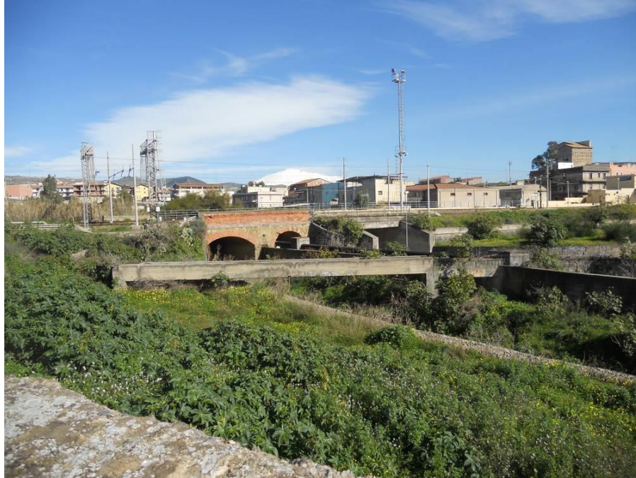
Figura 99 - Torrente Mulinello_Attraversamento ferroviario, vista da valle
