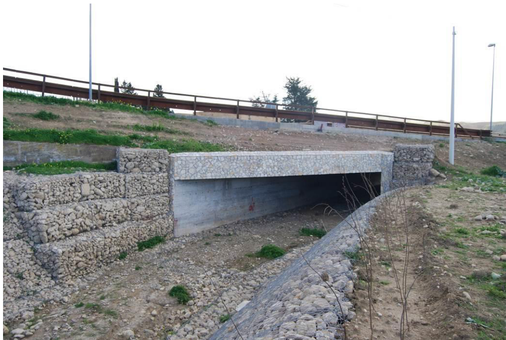
Figura 92 - Torrente Mastropaolo_Attraversamento via dei Caduti in Guerra, vista da monte
