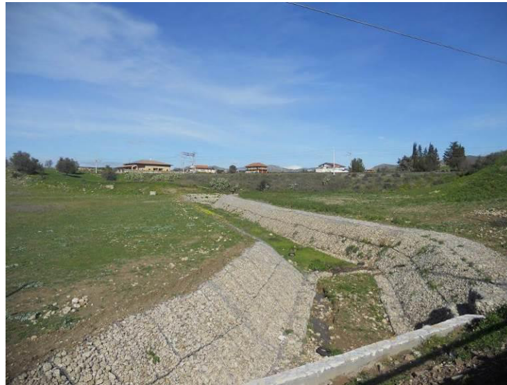
Figura 91 - Torrente Mastropaolo_Attraversamento ferroviario, vista da valle
