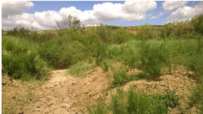
Figura 24 – Corso d'acqua alla progressiva 11+413.74_Foto in prossimità del nuovo viadotto
