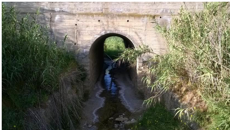
Figura 71 - Corso d'acqua alla progressiva 18+550_ Foto a valle ponte ferroviario esistente
