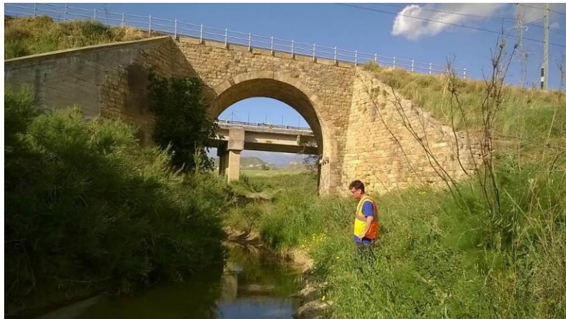
Figura 82 - Fosso Sparagogna_Foto ponte ferroviario da valle
