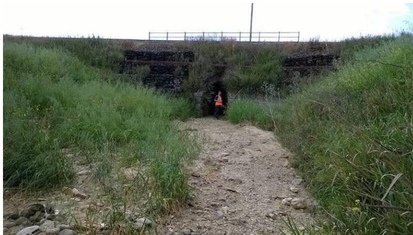
Figura 16 - Corso d'acqua alla progressiva 9+600_Foto a valle dell'attraversamento ferroviario.
