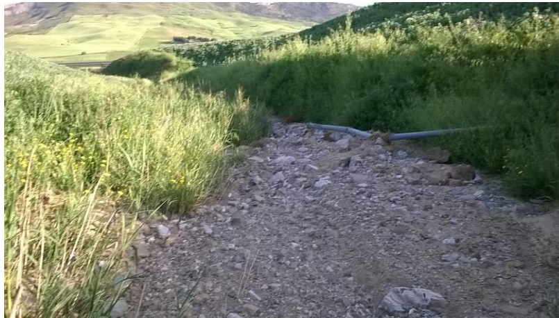
Figura 72 - Corso d'acqua alla progressiva 18+550_Foto a valle attraversamenti esistenti
