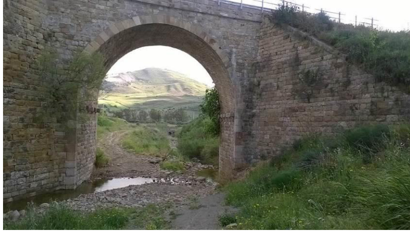
Figura 81 - Fosso Sparagogna_Foto ponte ferroviario da monte
