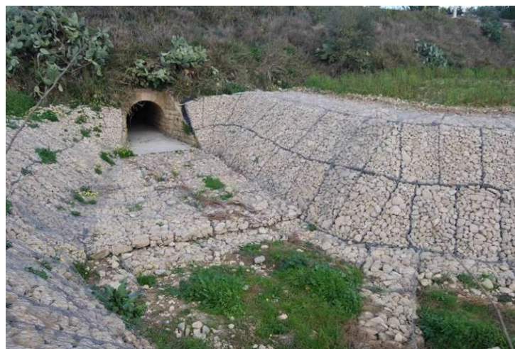
Figura 90 - Torrente Mastropaolo_ Attraversamento ferroviario, vista da valle
