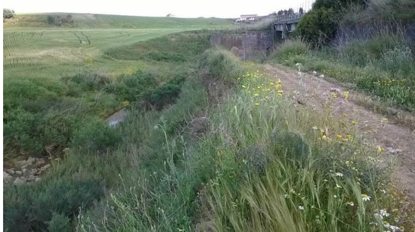
Figura 78 - Fossa Sparagogna_Foto a monte attraversamento stradale
