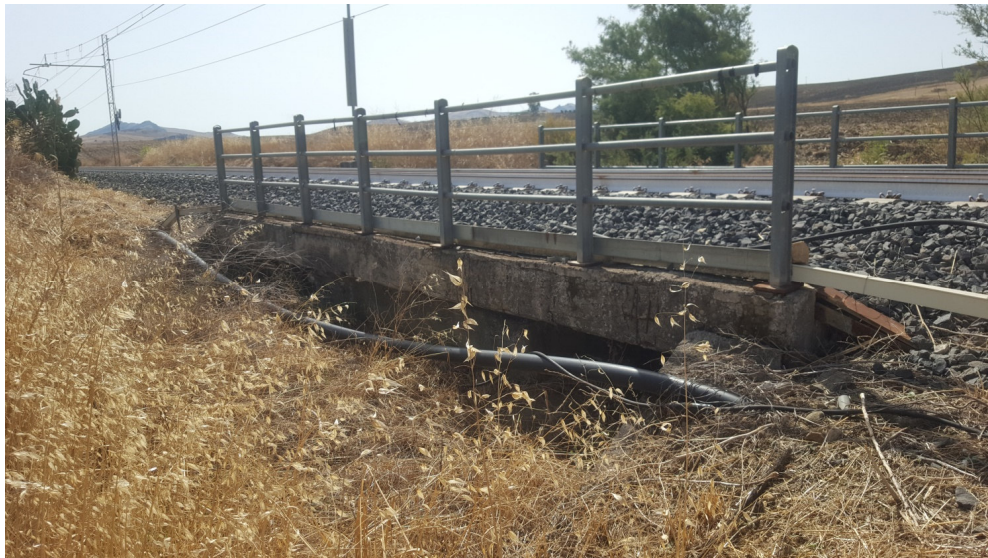
Figura 10 – Foto attraversamento ramo di valle nello stato di fatto.
