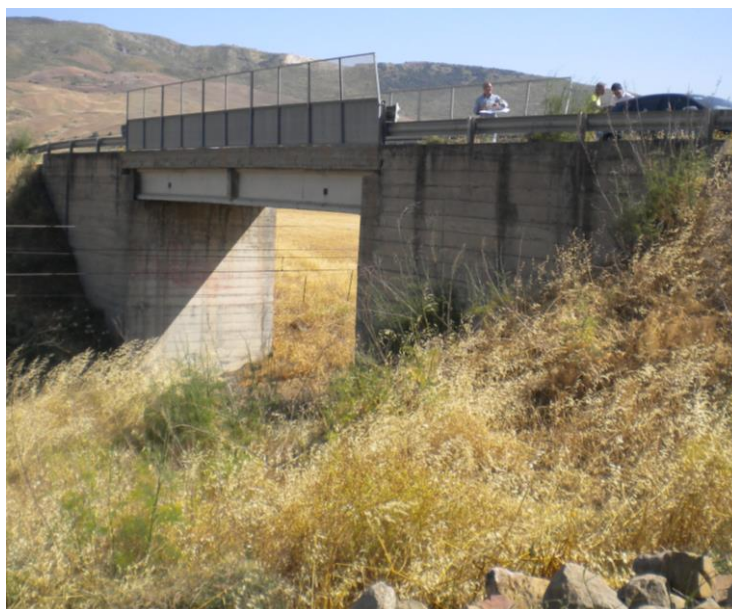
Figura 3 CVF esistente in prossimità della masseria Zito
