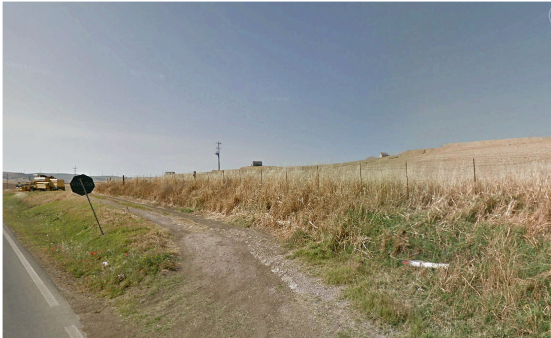
Innesto Strada poderale con SS192
