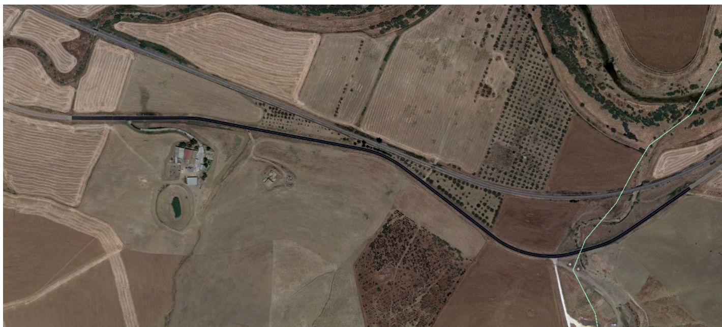
Stato di fatto: S.S. 162 della Valle del Dittaino - tratto tra progr. 25+780 e progr. 26+750 (progressive Anas)
