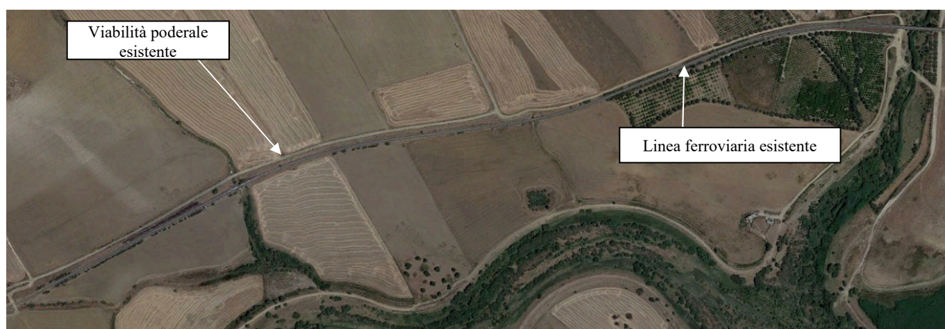
Fig. 1 - Stato di fatto
