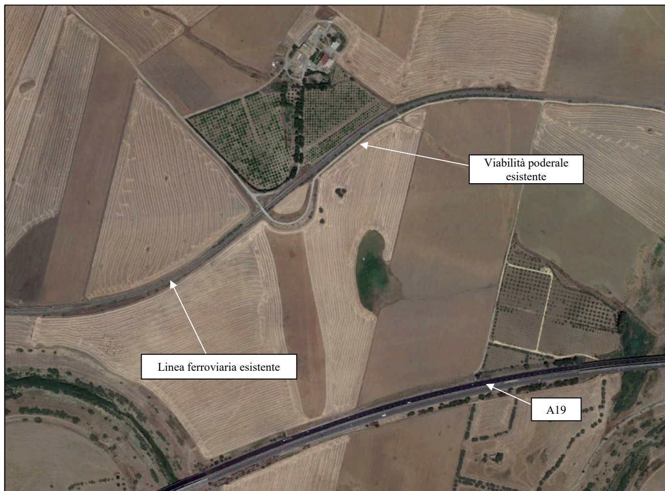
Fig. 1 - Stato di fatto
