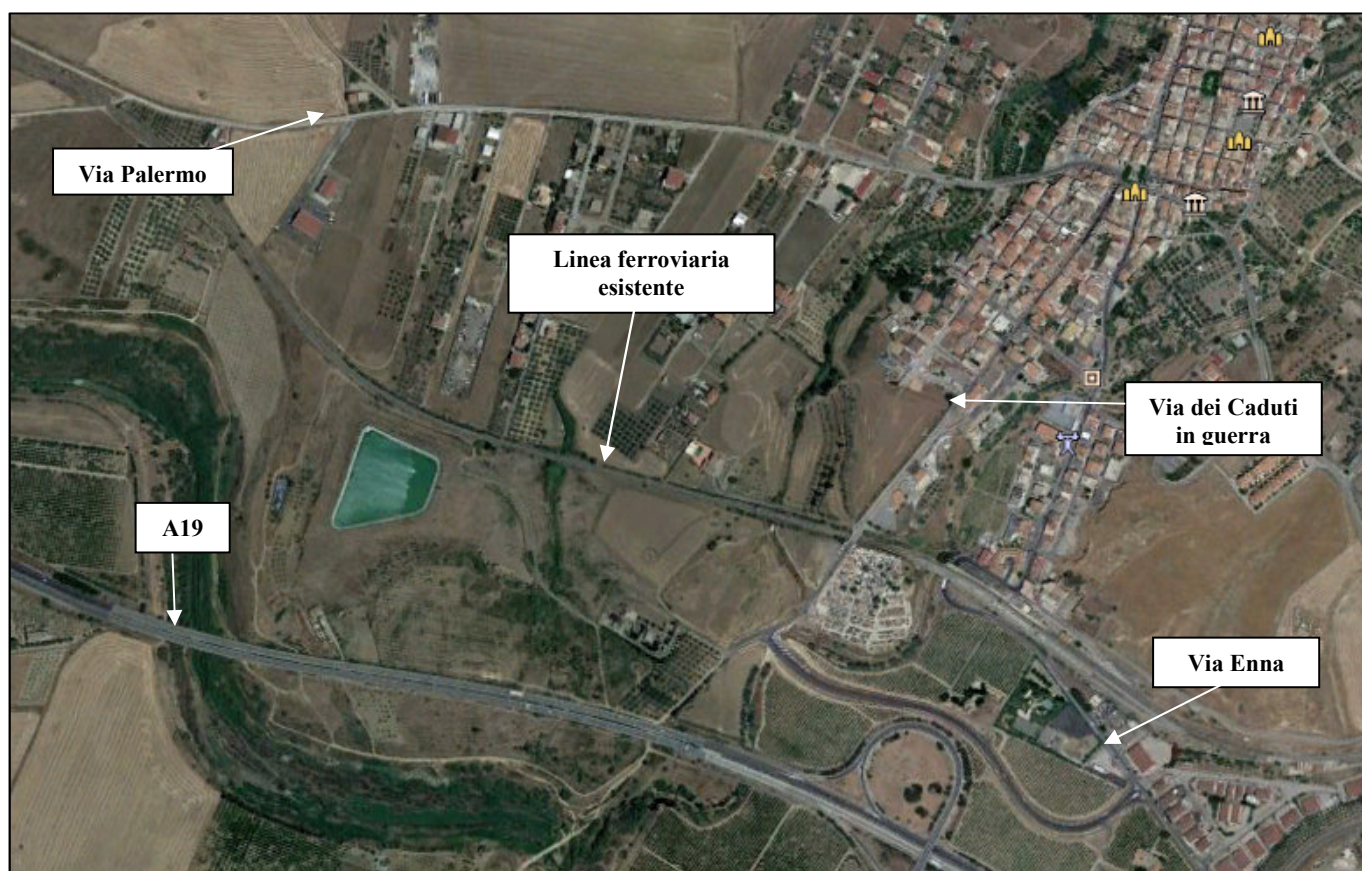
Fig. 1 - Stato di fatto
