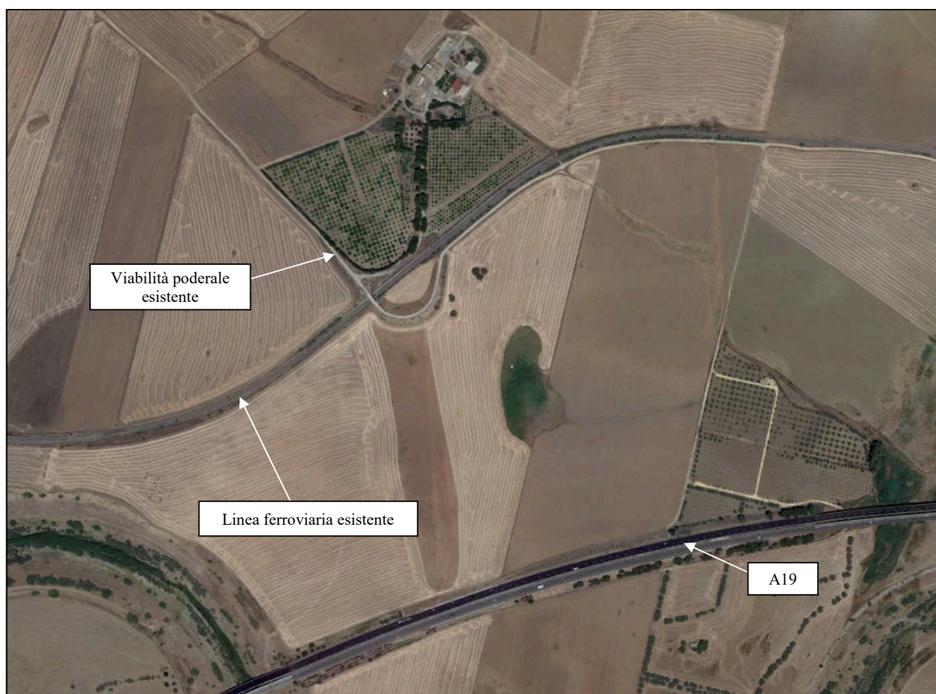
Fig. 1 - Stato di fatto
