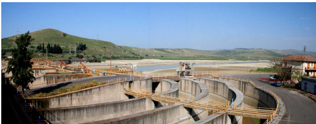
Figura IV.3 - La Traversa Barca nella parte settentrionale dell'area di indagine
