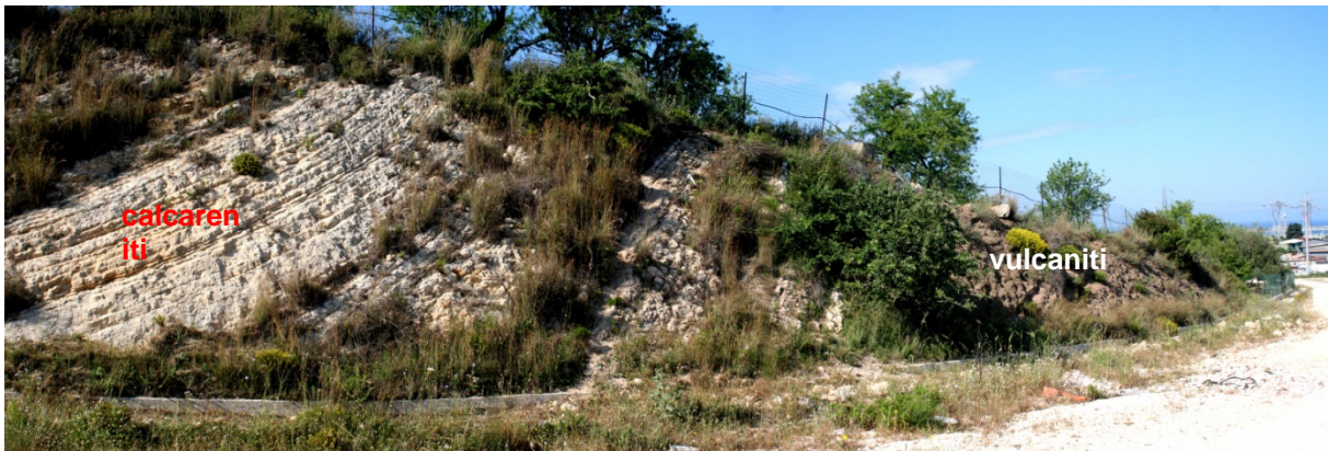
Figura 4.41 - Contatto in affioramento tra calcareniti (sx) e vulcaniti (dx) nella parte terminale del tracciato, nei pressi della S.E. Priolo Gargallo
