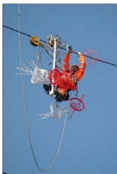
Figura 4.45 - Montaggio di dissuasori visivi
