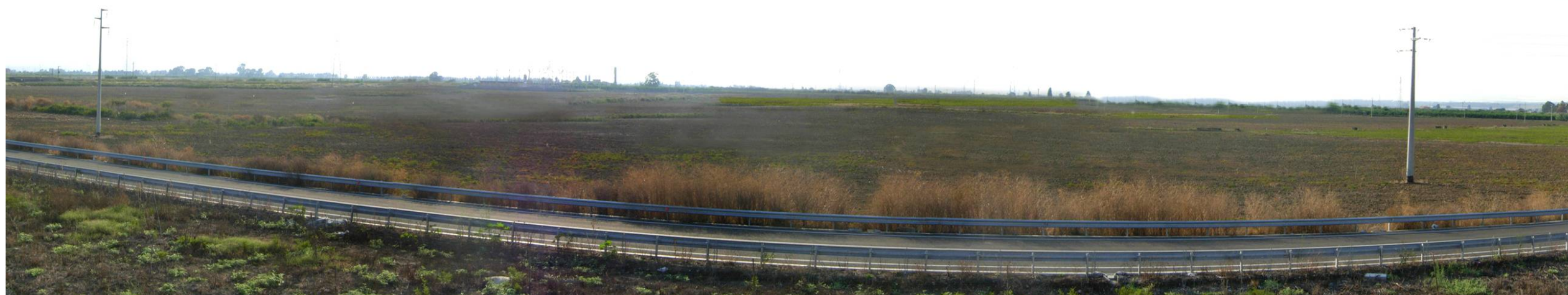
Stazione Elettrica di Pantano e relativi raccordi - Punto di ripresa fotografica P15
