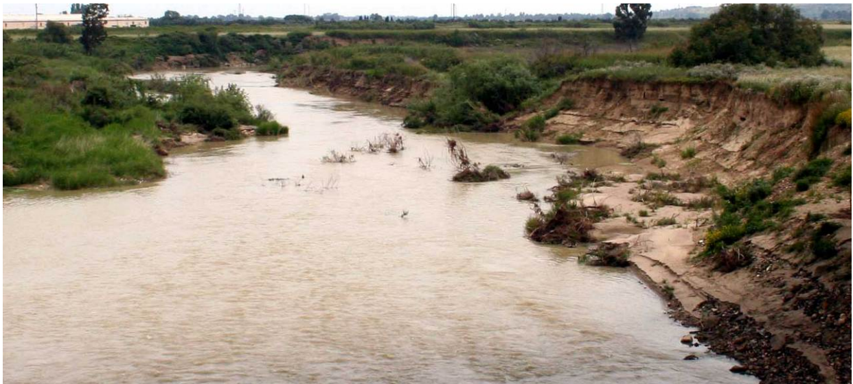
Figura 2.16 -Erosione al piede della scarpata fluviale del Simeto
