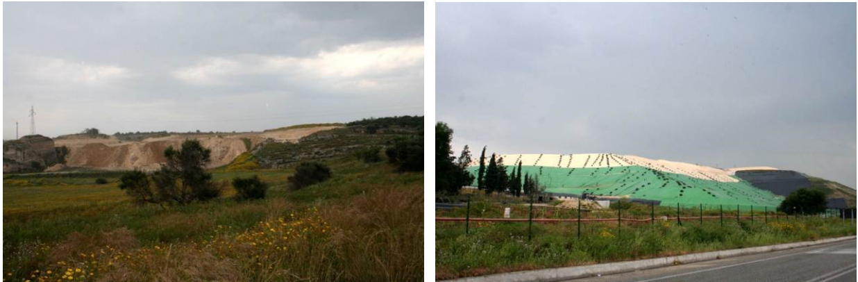
Figura 2.15 -Fronte di cava (sx) e discarica (dx) nel tratto B19-B23
