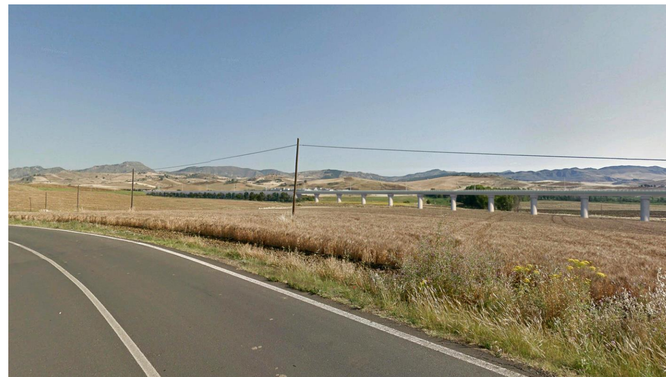
Figura 4-17 Piana del Dittaino primo approfondimento di analisi. Condizioni percettive post operam
