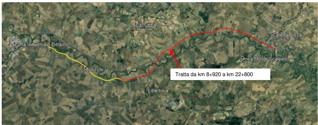
Figura 1 - Inquadramento linea ferroviaria su ortofoto.
