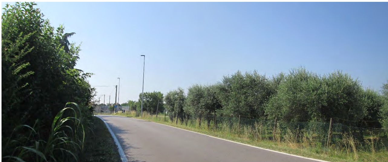
Foto 15 - Via Grezze – Lato nord autostrada – Inizio variante
