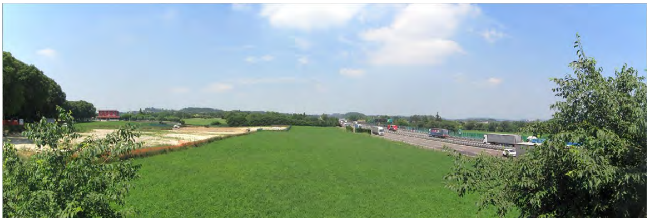
1 - Vista dal cavalcavia di via Bornade – Lato sud Autostrada – Sulla sinistra l’area interessata dalla costruzione della linea AV/AC
