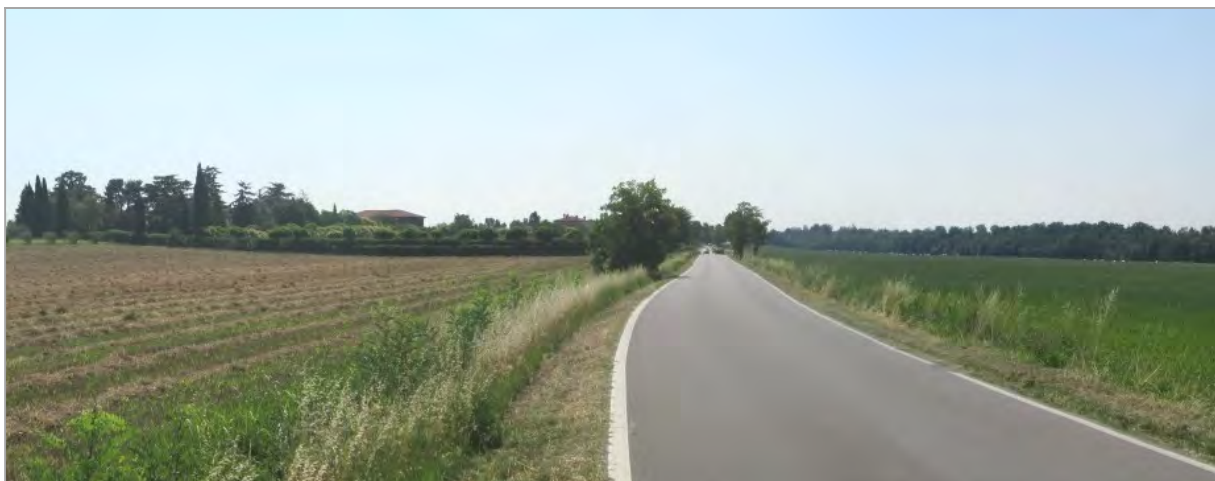
Foto 9 - Via Grezze – Lato sud autostrada - Vista in prospettiva sud
