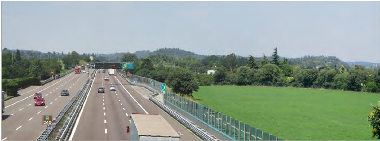
2 - Vista dal cavalcavia di via Bornade – Lato nord Autostrada
