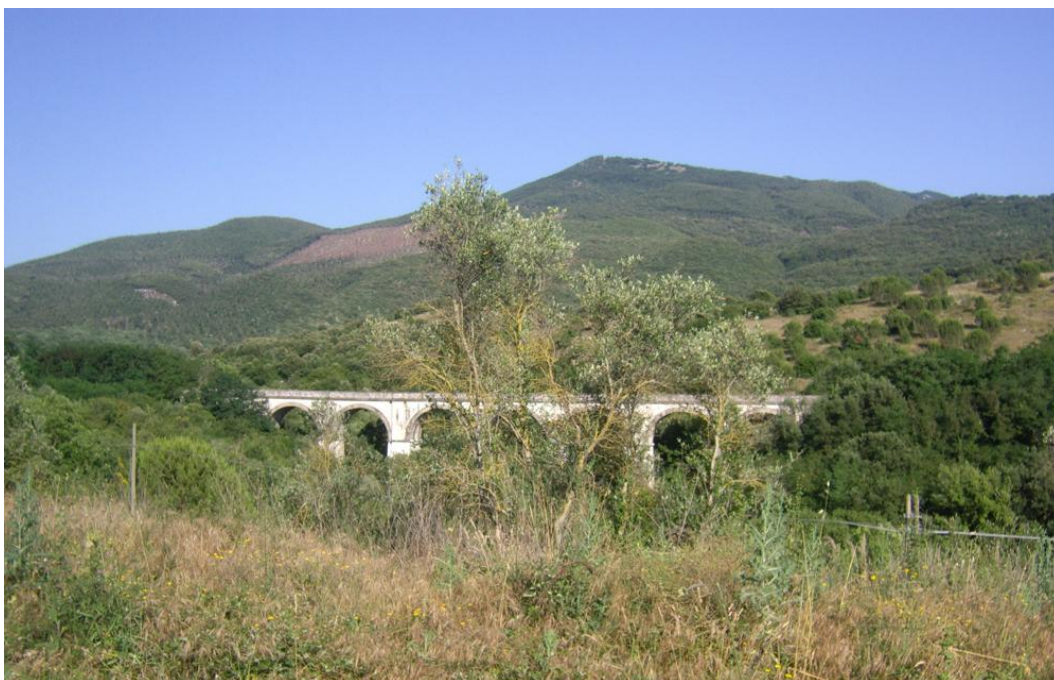
Figura E.2: Ponte ferroviario: esempio di manufatto di carattere testimoniale
