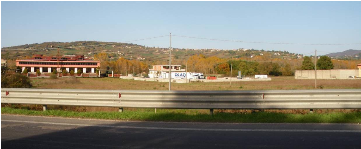
Figura D.10: Veduta dell'area all'altezza dello Svincolo di Bojano Sud
