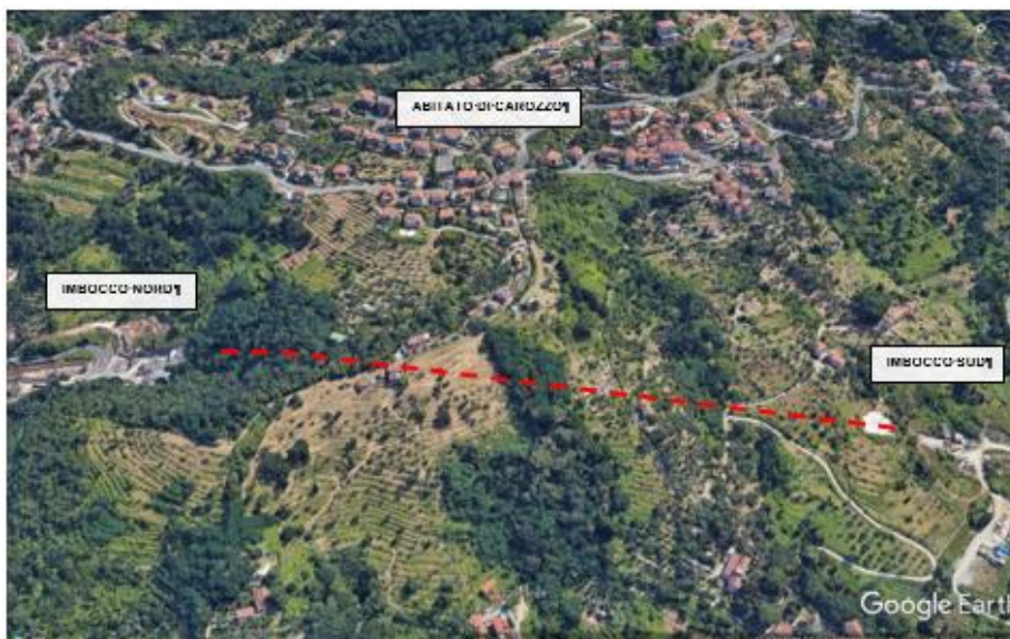
Figura 7.1 – Vista dell'area della galleria Felettino I adiacente all'abitato di Carozzo
