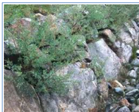
Fig. 2 Esempio di scogliera rinverdita con talee
