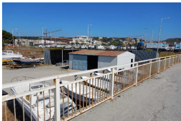
Vista su fabbricati esistenti angolo nord-est.
