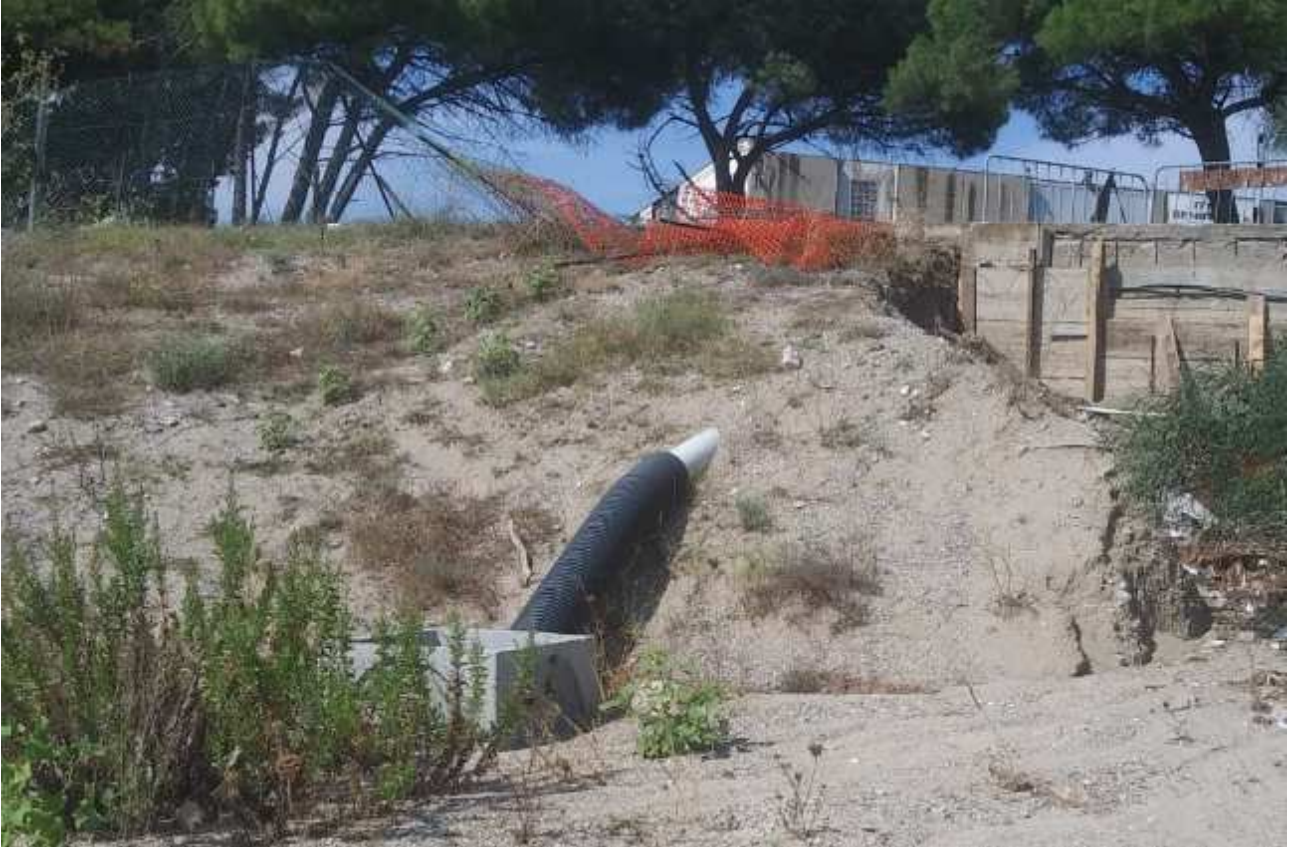
Foto 1 – Uno dei 5 collettori di scarico da strada sopraelevata
