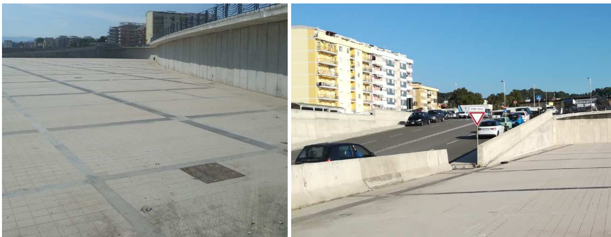
Foto 2 – Piazzale pavimentato e rampa stradale esistenti ad ovest dell'area d'intervento
