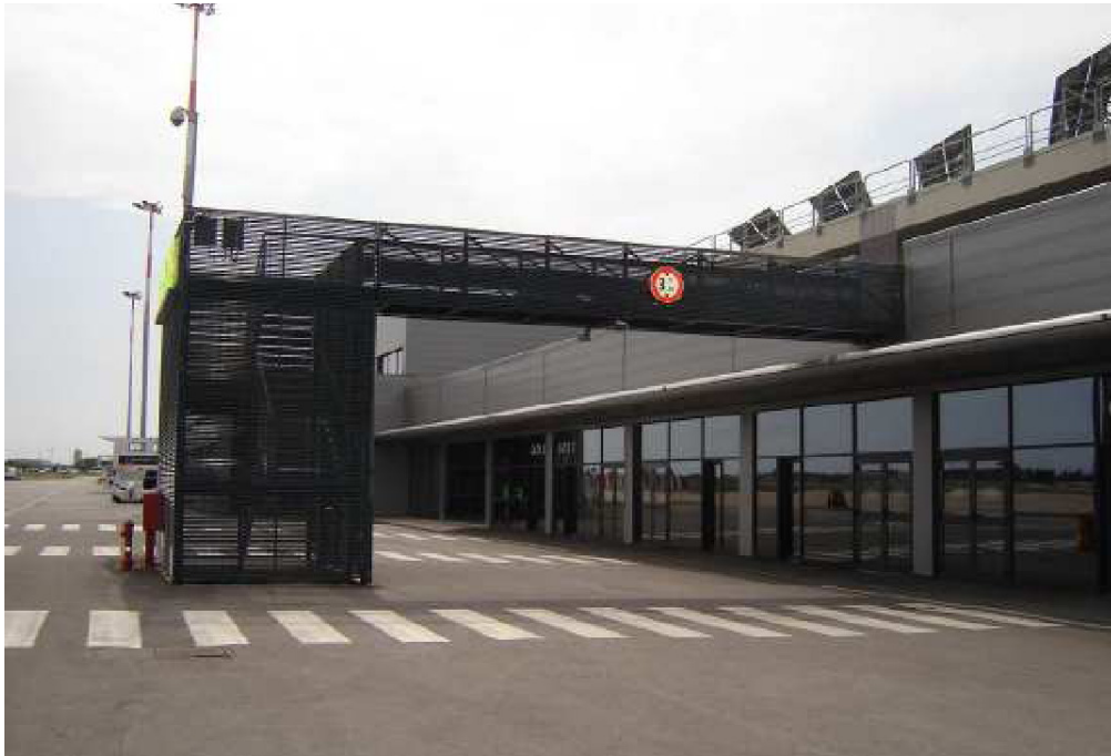
Figura 4-2. Scala di sicurezza metallica da conservare e inglobare nella nuova costruzione
