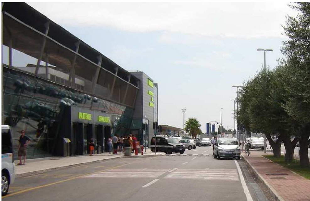
Figura 4-3. Prospetto land-side dell'aerostazione di Brindisi
