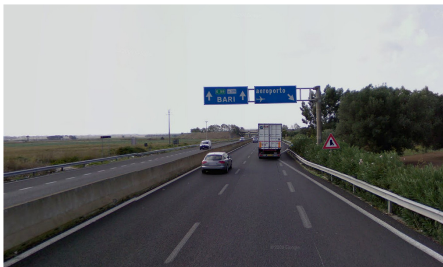
Figura 3-13. SS 379 in prossimità dell'uscita per l'aeroporto
