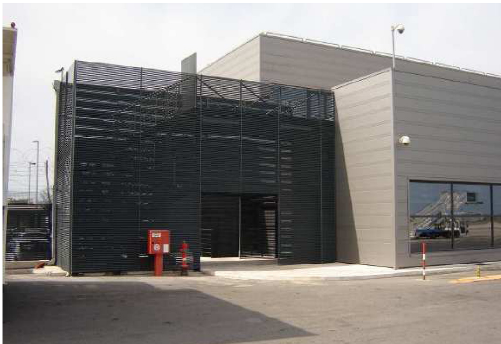
Figura 4-1. Terrazzo su locali BHS: futura ubicazione nuovo ascensore esterno
