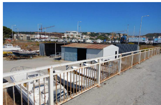
Vista su fabbricati esistenti angolo nord-est.
