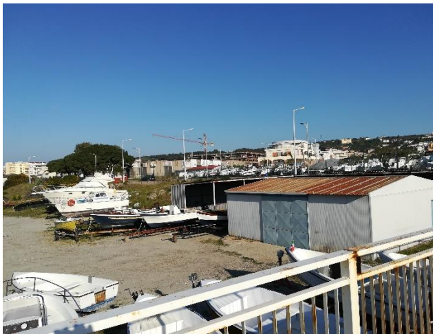
Area di cantiere
