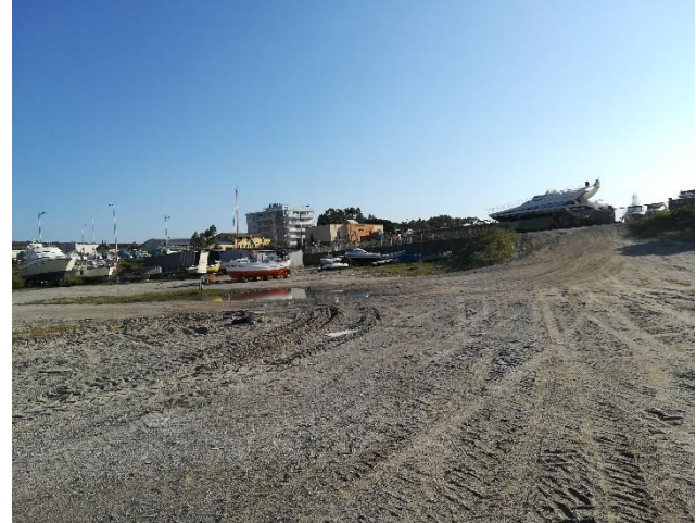
Area di cantiere
