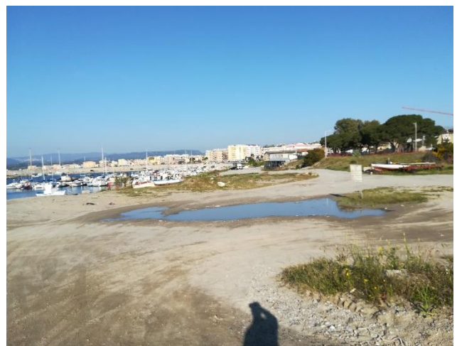
Area di cantiere
