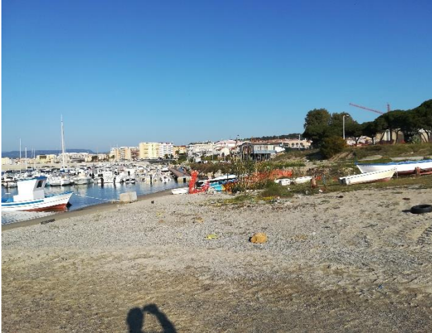
Area di cantiere
