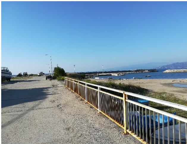
Accesso all'area di cantiere
