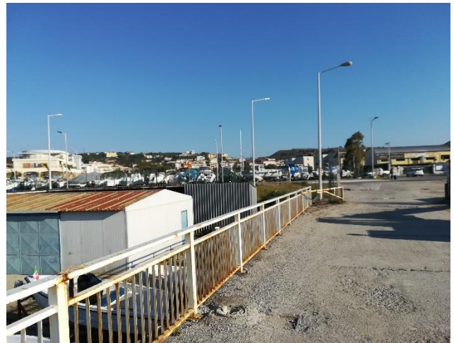
Accesso all'area di cantiere
