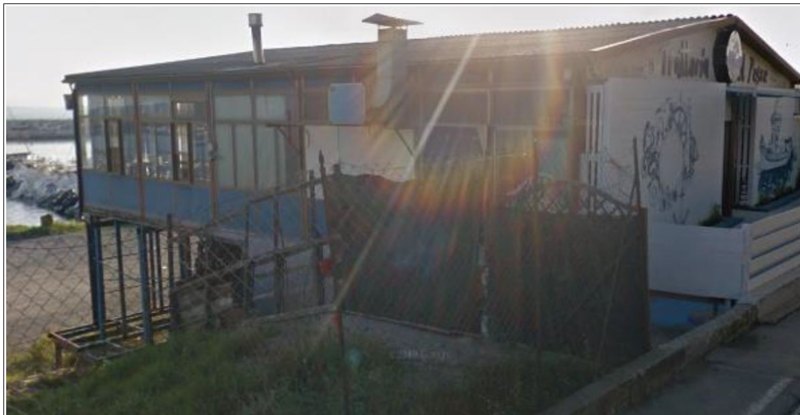
Figura 25 - Fabbricato da demolire prima dell'inizio dei lavori e non previsto nel progetto definitivo
