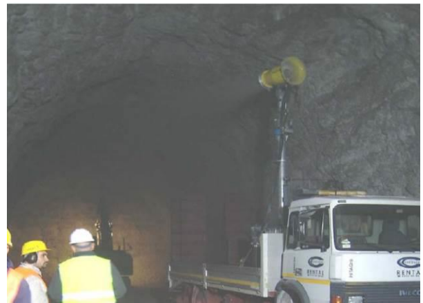
Martelloni: utilizzo combinato di ugelli a bordo macchina e di un piccolo cannone nebulizzatore
