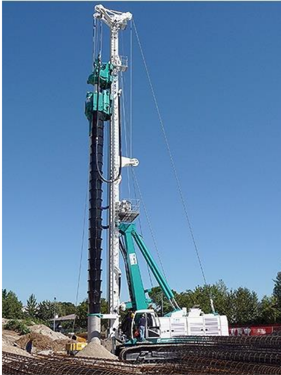
Perforatrice e tubazione telescopica
