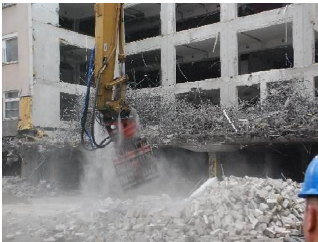
Martelloni: ugelli nebulizzatori per il contenimento laterale delle emissioni di polveri residue
