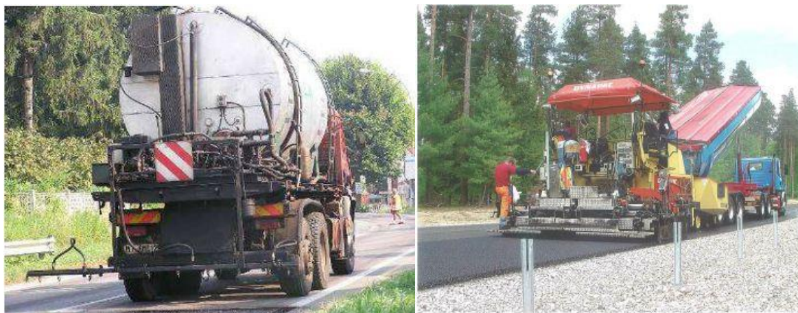
FIGURA 5.1-2 – A SX APPLICAZIONE DI EMULSIONE BITUMINOSA, A DX VIBROFINITRICE
