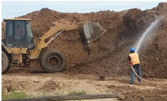
Irrorazione di acqua su un cumulo di terra prima della fase di presa per il carico
