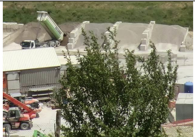
Baie di stoccaggio inerti chiuse su tre lati: l'altezza dei cumuli di materiale è scorretta perché supera l'altezza del muro finale
