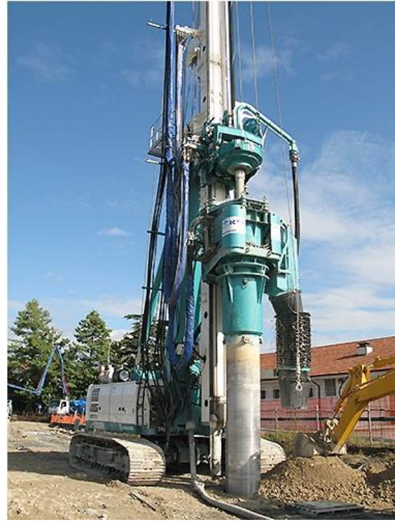
Perforatrice e tubazione telescopica
