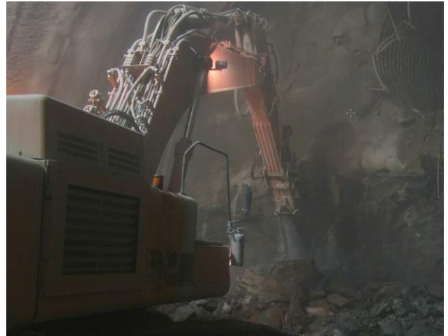
Martelloni: ugelli di lavaggio del materiale in caduta
