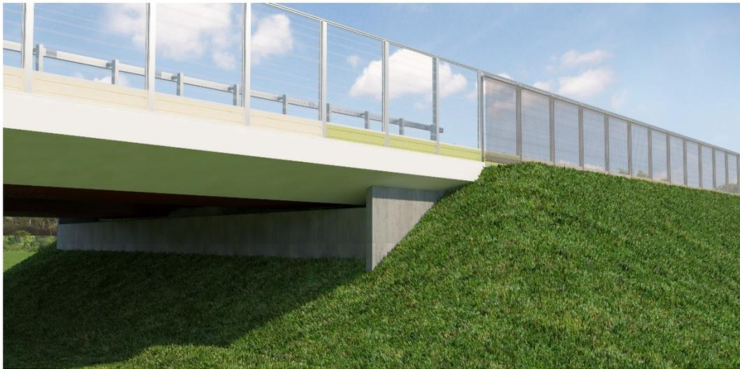
**FIGURA 7-12 –TRATTO DI TRANSIZIONE VIADOTTO-RILEVATO**
