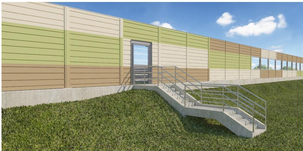
**FIGURA 7-16 –SCALA DI SICUREZZA IN CORRISPONDENZA DELLE BARRIERE DI PROTEZIONE ACUSTICA: VISTA LATO RICETTORE**
