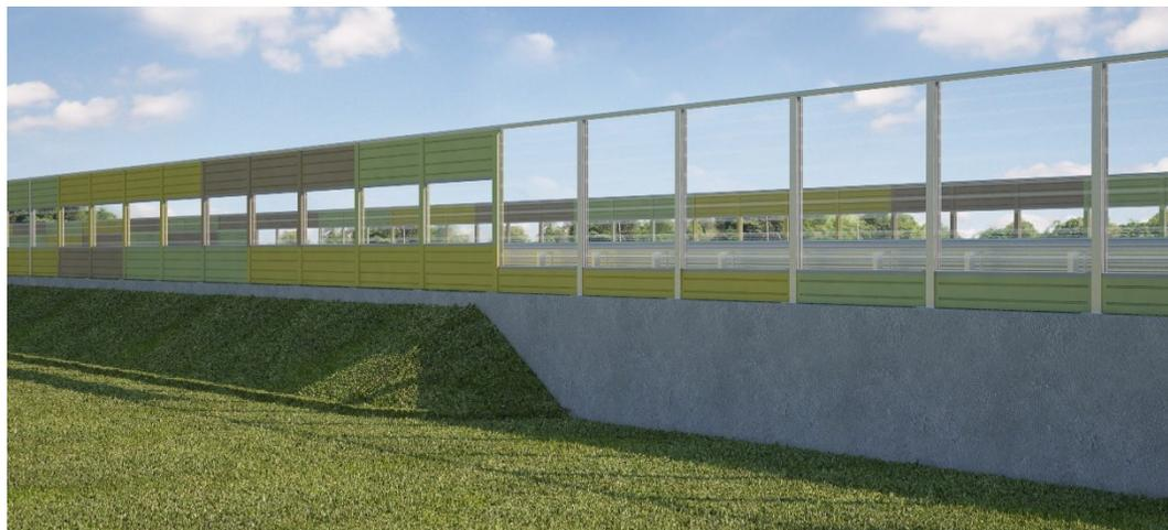
**FIGURA 7-14 –TRATTO DI TRANSIZIONE RILEVATO-MURO DI SOSTEGNO**
