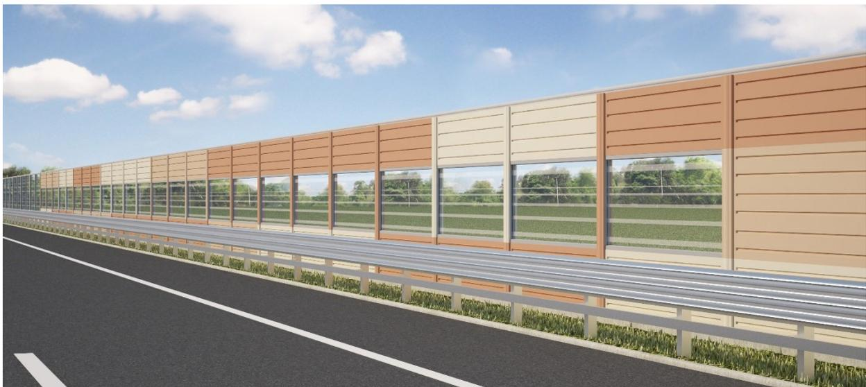
**FIGURA 7-6 – BARRIERA ACUSTICA MISTA FONOASSORBENTE-FONOSOLANTE SU RILEVATO – VISTA LATO SORGENTE**
