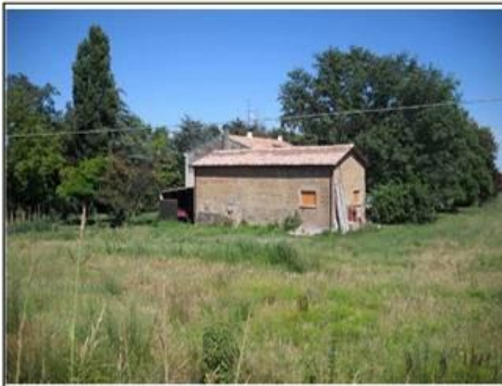
Vista da: Ovest
