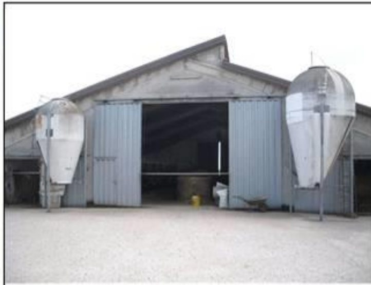
Vista da: Nord
