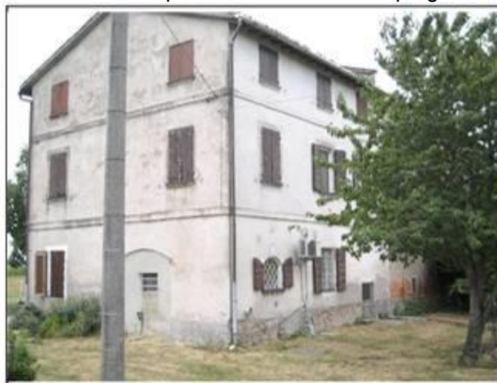
Vista da: Nord
