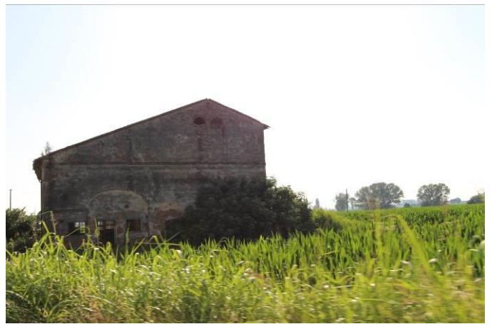
Vista da: Nord
