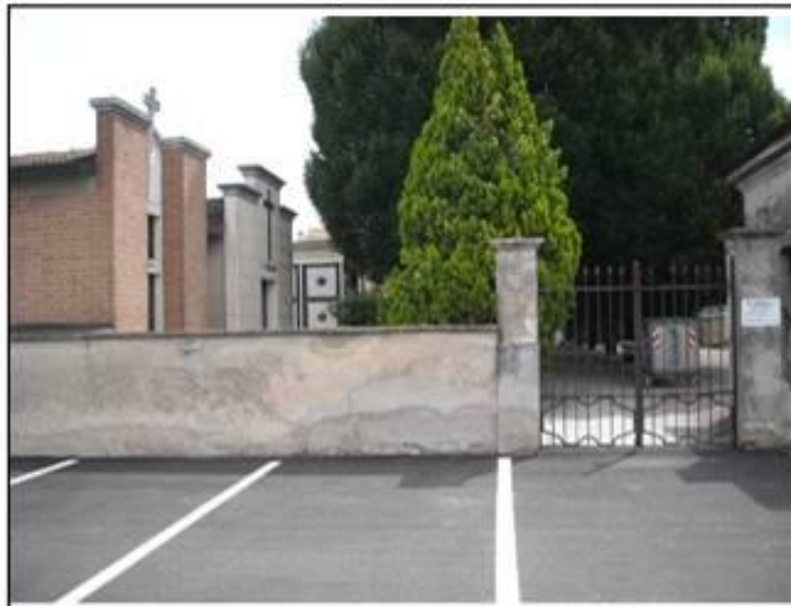
Vista da: Ovest
