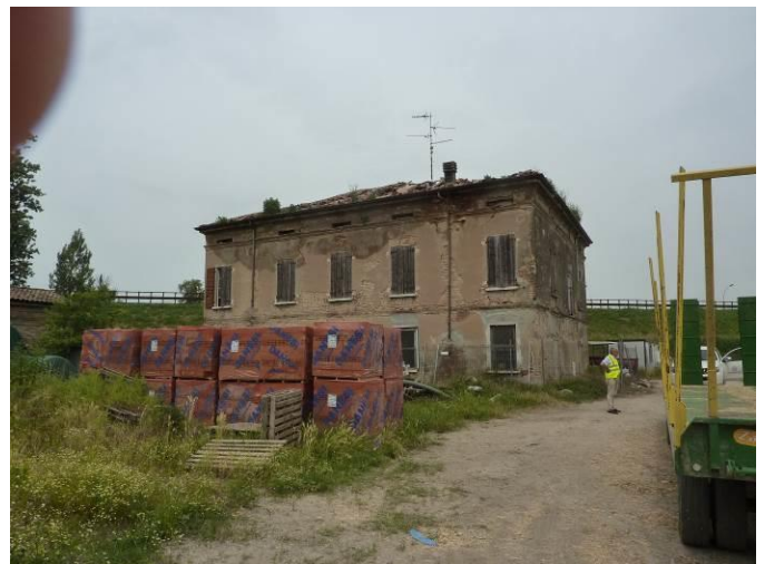
Vista da: Nord
