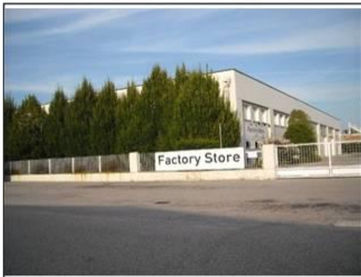
Vista da: Sud Ovest
