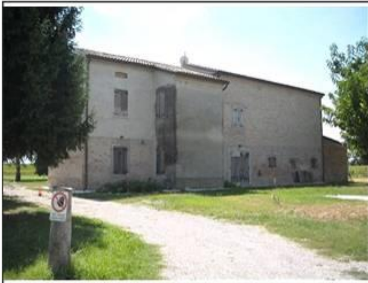
Vista da: Nord
