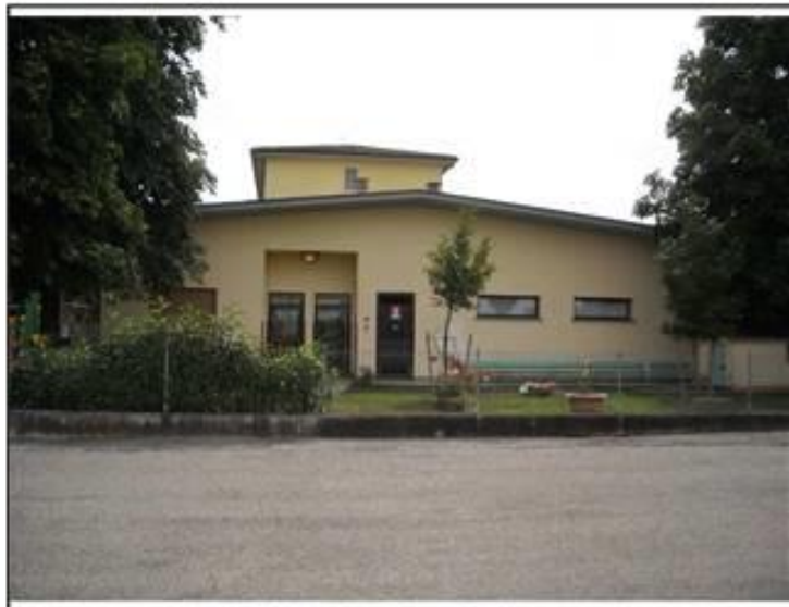
Vista da: Ovest
