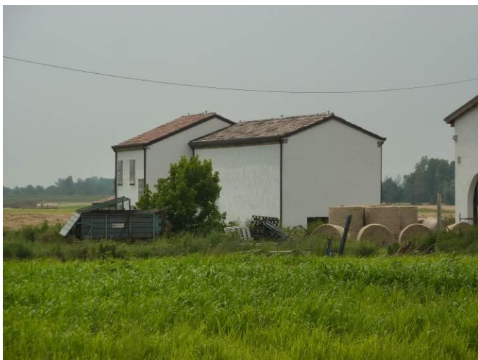
Vista da: Nord
