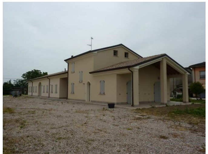
Vista da: Nord
