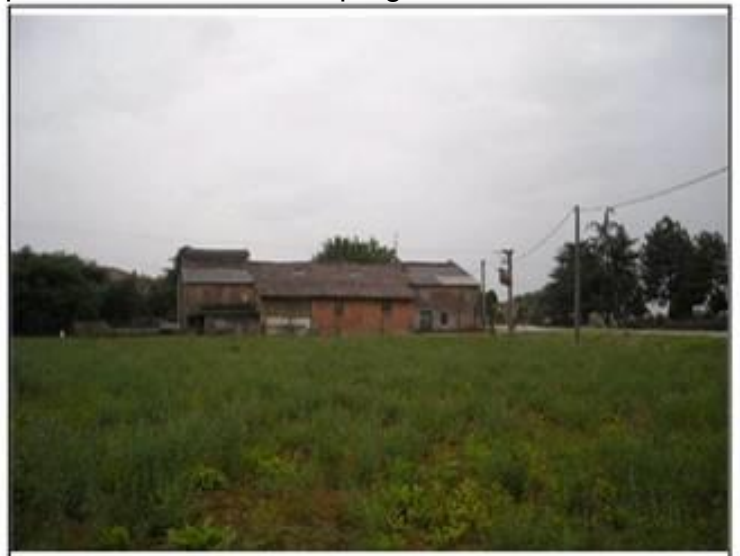
Vista da: Nord
