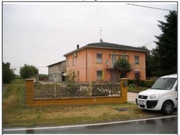
Vista da: Nord
