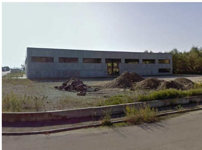
Vista da: Nord
