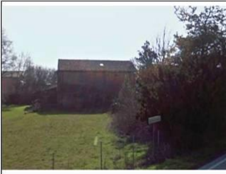
Vista da: Nord
