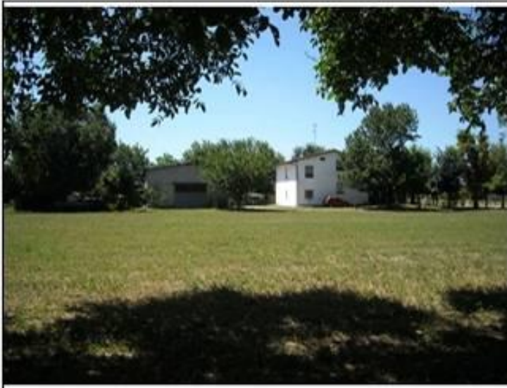
Vista da: Nord
