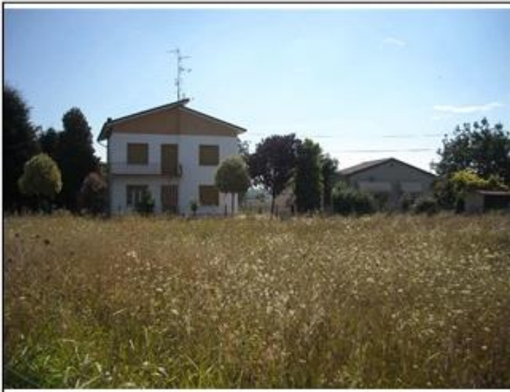
Vista da: Ovest
