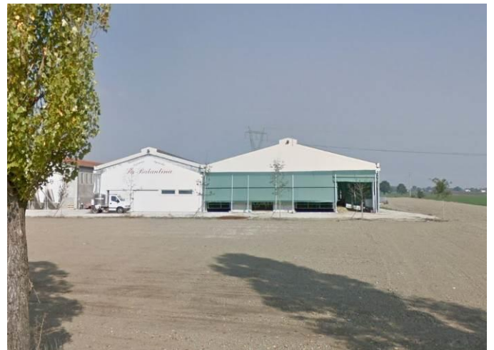
Vista da: Nord
