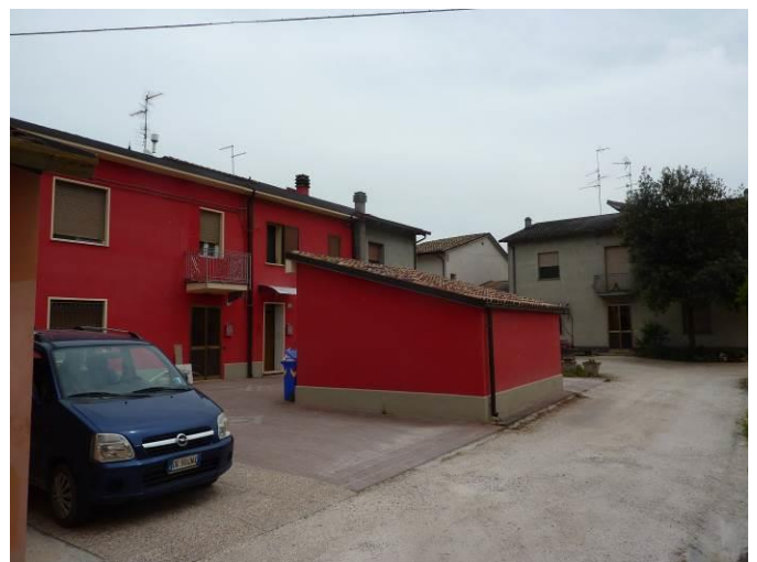
Vista da: Nord
