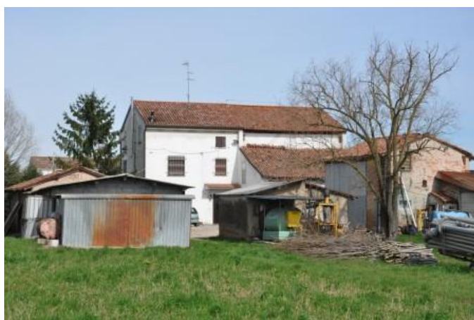
Vista da: Ovest
